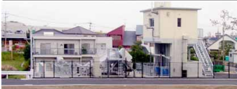
鴨園川排水機場 処理能力: 4.0 m 3 / 秒
