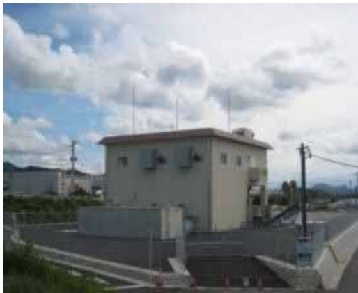
北鼻川排水機場 処理能力: 14.0 m 3 / 秒
