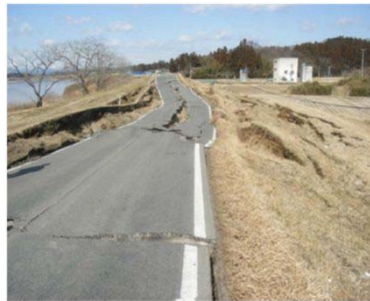
地震による堤防の被災状況
