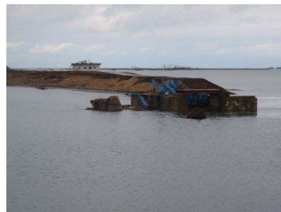
地震による水門の被災状況
