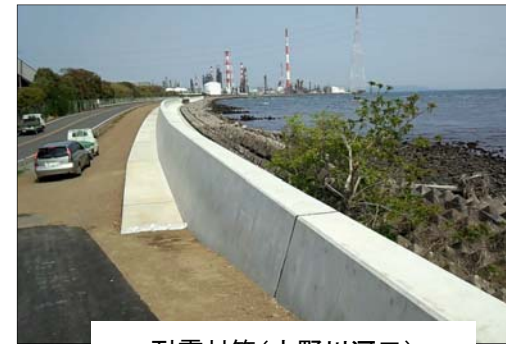
耐震対策(大野川河口)
