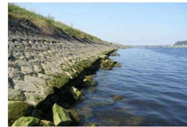
護岸の損傷(3k800付近)
