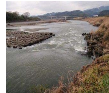
導水路床固の損傷(12k400付近)
