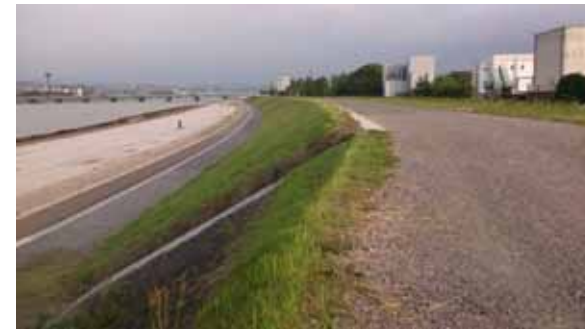
耐震対策(大分川河口)
