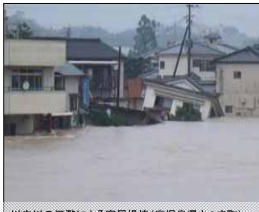
川内川の氾濫による家屋損壊(鹿児島県さつま町)
