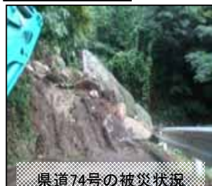
県道74号の被災状況 (鹿児島県南大隅町)
