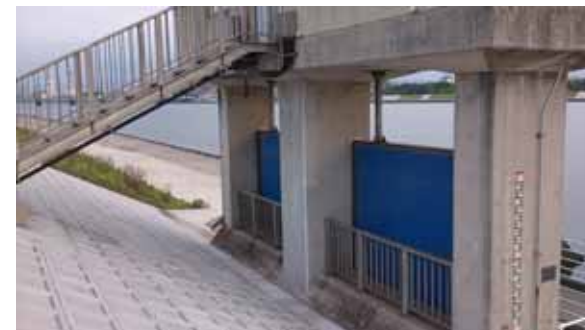
耐震対策(津留樋管)
