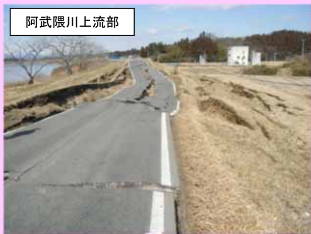
地震による堤防の被災状況
