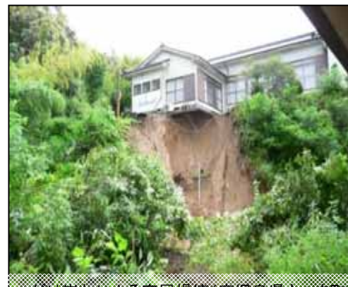
がけ崩れによる家屋損壊(鹿児島県さつま町)
