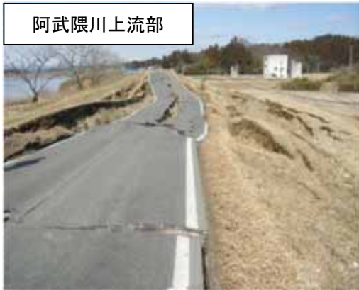
地震による堤防の被災状況
