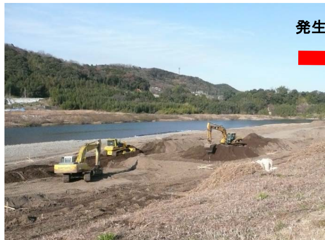
河道掘削状況
