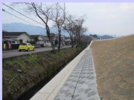
堤防裏法尻の補強
