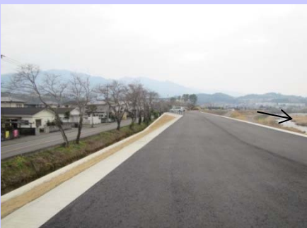
堤防天端の保護
