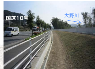
①堤防整備[築堤] (利光地区)
