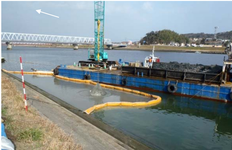
河床低下対策(根固の投入)
