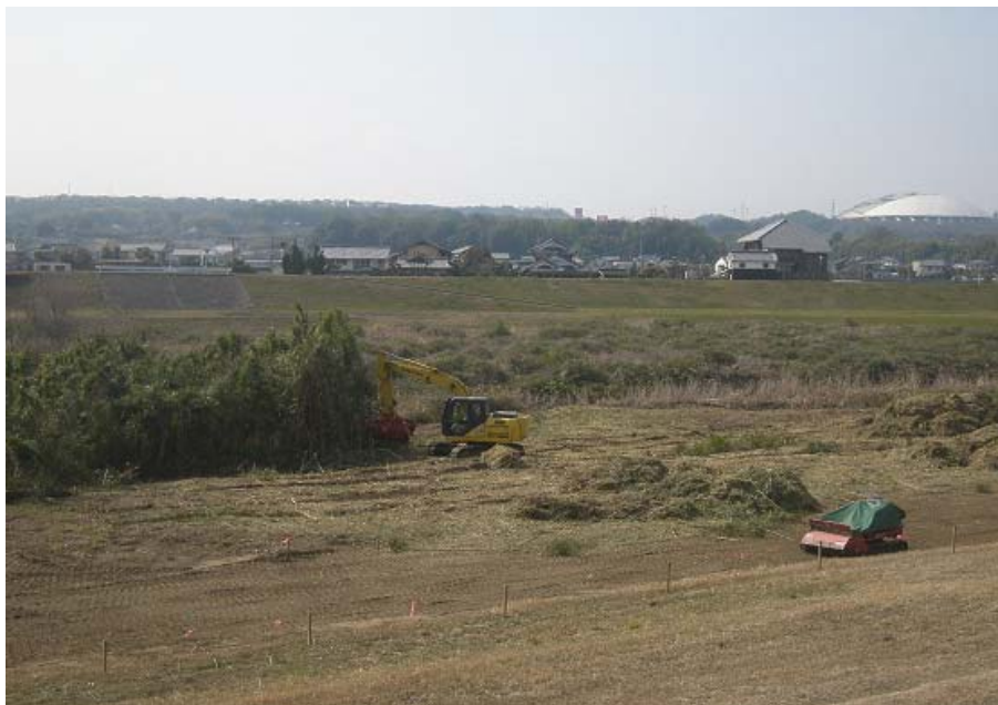
洪水時に支障となる河川内の樹木を河川環境に配慮しながら伐採
