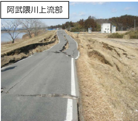
地震による堤体の変状
