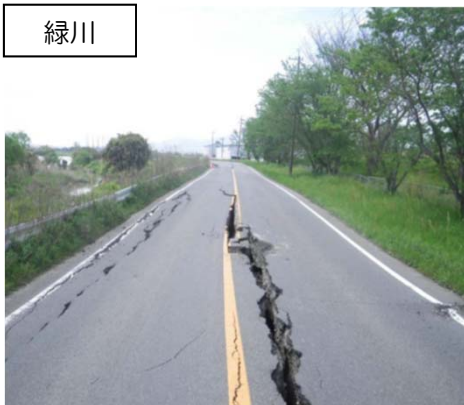
地震による堤体の変状
