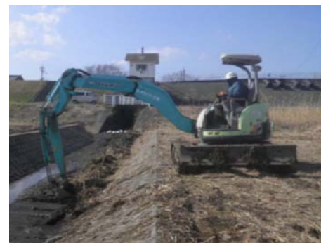
樋門樋管等の操作に支障となる河川内に堆積した土砂等を撤去
