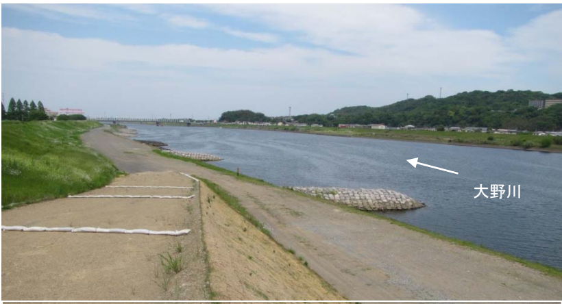
水制工設置状況
