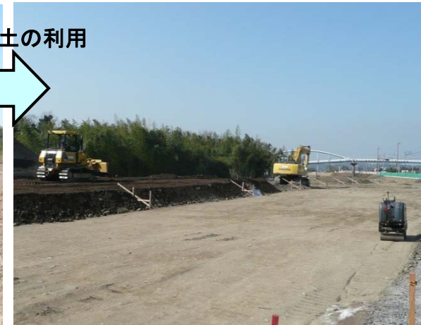
堤防整備状況
