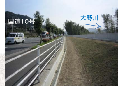
①堤防整備[築堤] (利光地区)
