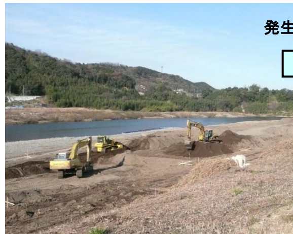
河道掘削状況
