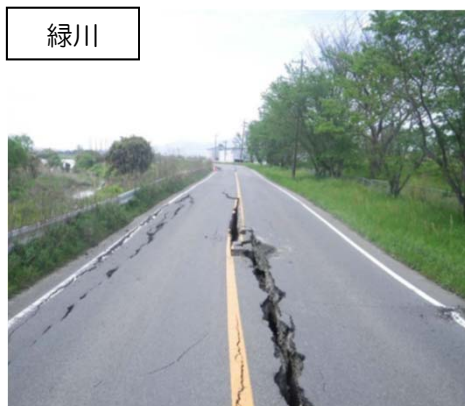
地震による堤体の変状
