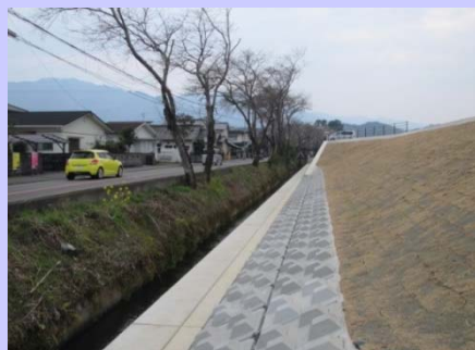
堤防裏法尻の補強
