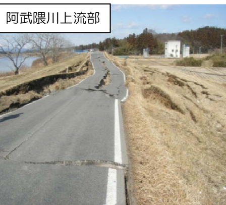
地震による堤体の変状
