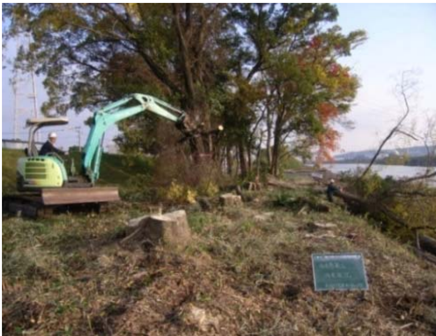
洪水時に支障となる河川内の樹木を河川環境に配慮しながら伐採
