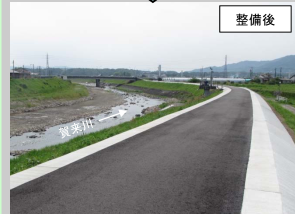
賀来地区の堤防天端舗装・法肩補強
