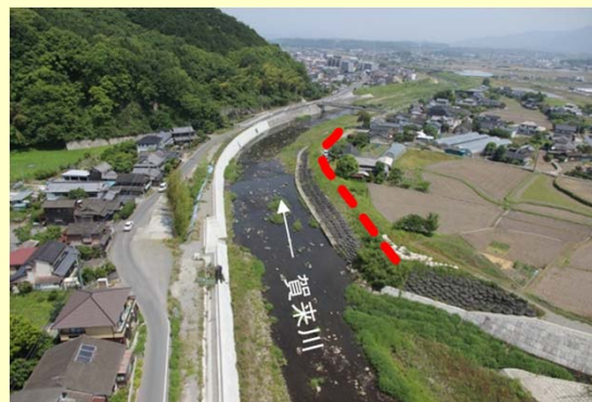
下流右岸の築堤護岸 実施予定箇所
