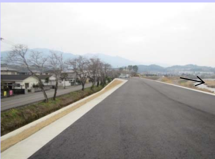
堤防天端の保護
