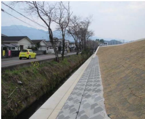
堤防法尻対策状況 (大分川右岸小野鶴地区)
