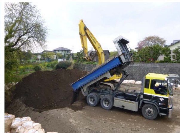
掘削土搬入状況（土地区画整理事業）
