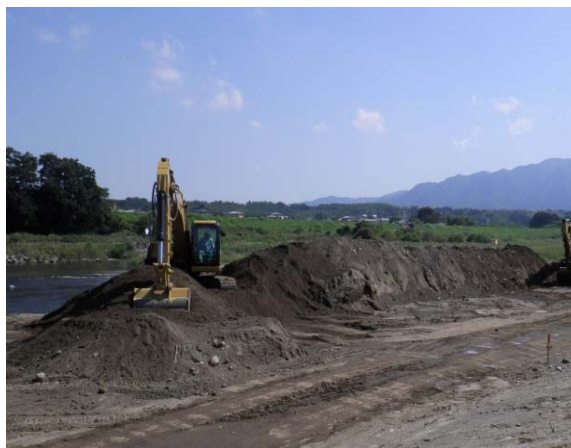
河道掘削状況（大分川）
