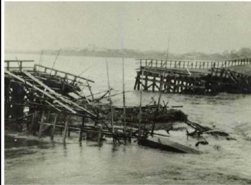
昭和28年6月洪水 流出した舞鶴橋(大分川)
