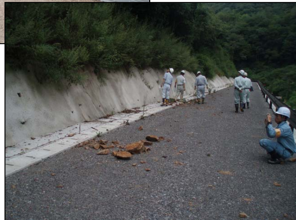
地震直後に発生した落石状況
