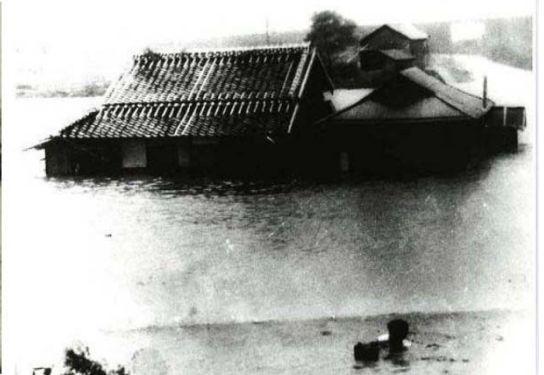
昭和32年9月洪水 大分市明礮地区の浸水被害(大分川)
