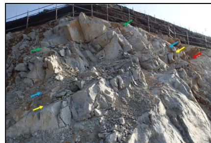
原石山掘削後に確認された脆弱な閃緑岩
