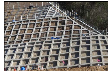
法面对策として法枠+アンカー工に変更
