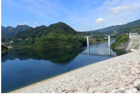
試験湛水状況(平成30年6月・ダム堤体より)
