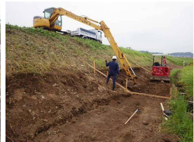
整備前 堤防法尻対策
