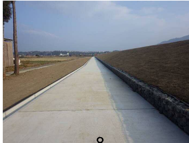
整備後 堤防浸透対策(ドレーン工)
