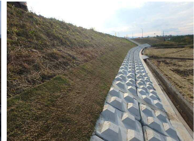
整備後 堤防法尻対策
