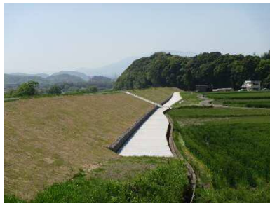
⑤ 国分地区堤防の質的対策
