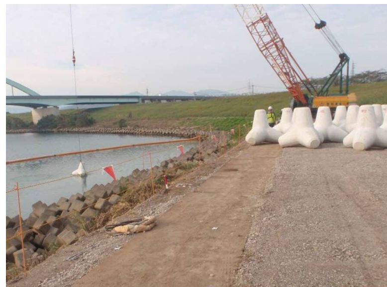
河床低下対策(根固の投入)
