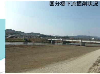
⑧ 横瀬・国分地区築堤及び掘削
