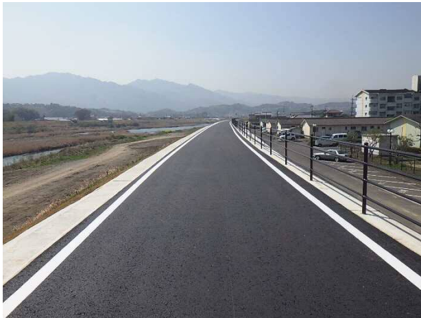
整備後 堤防天端舗装
