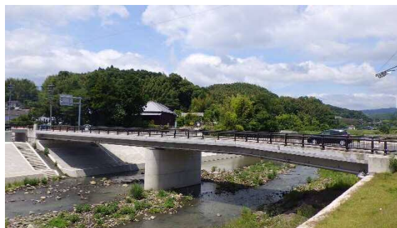
由布川橋 整備状況 7
