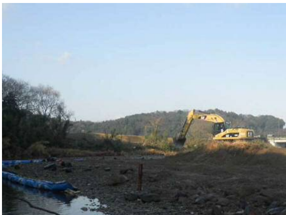
■ 河道の堆積土砂の撤去
