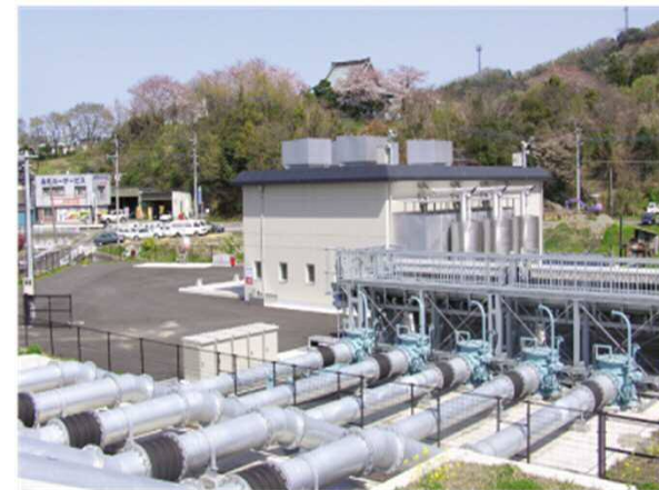
■ 排水機場等の補修・更新等
