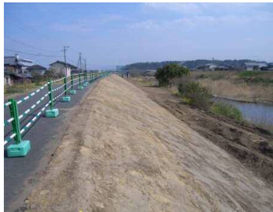
■ 堤防法面の損傷の補修
