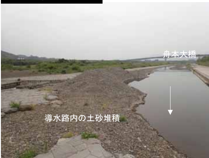
乙津川導水路の状況
