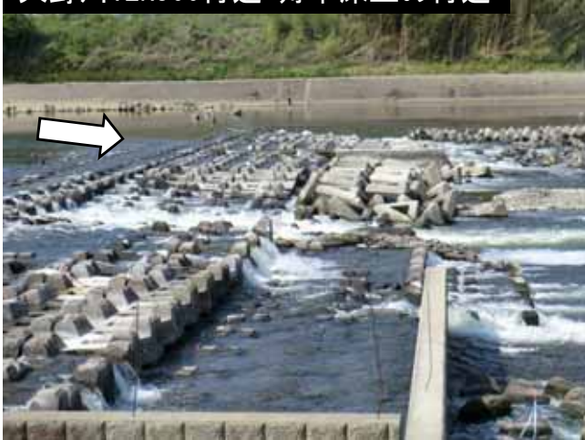
大野川12k500付近 舟本床止め付近
