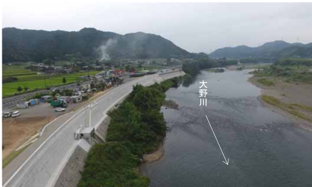
利光地区築堤（完了）
