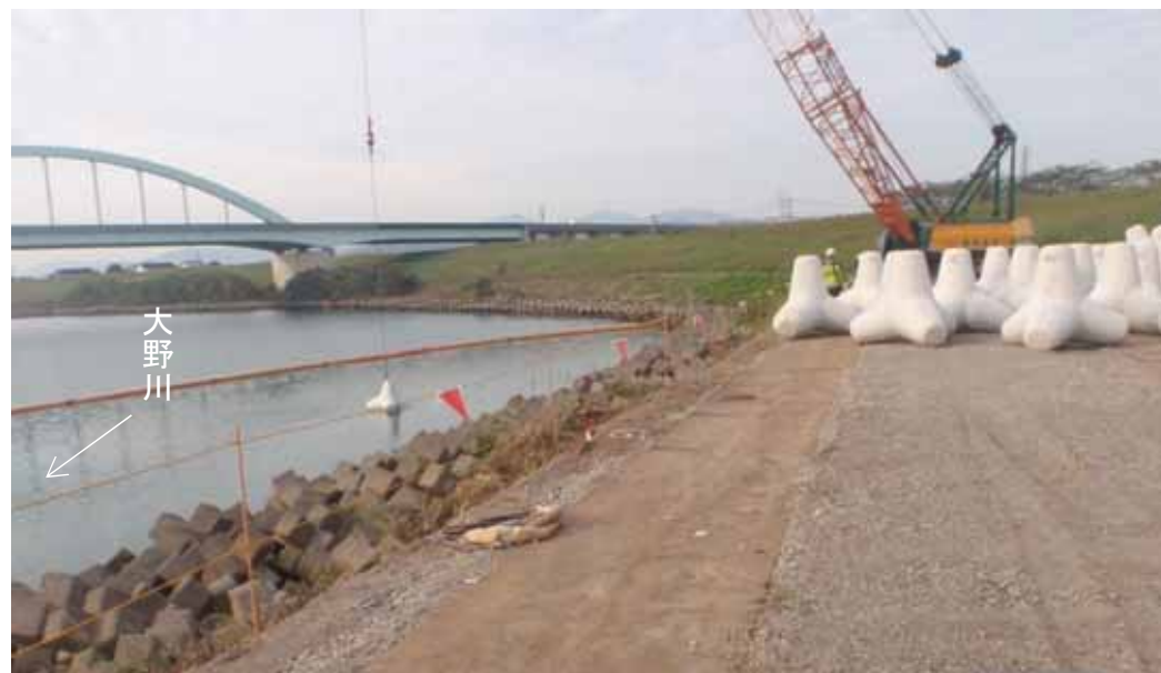
大津留地区河床低下対策（左岸8/400～8/600完了）
