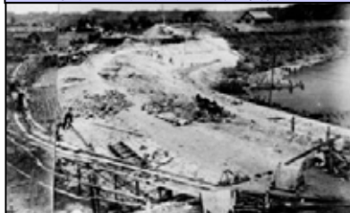
昭和18年当時の築堤状況(大野川) (昭和18年9月洪水決壊箇所)
