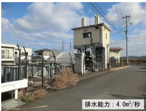
写真 2.1.3 鴨園川排水機場(平成 19 年度完成)
