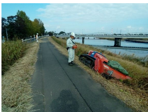
写真 5.3.2 堤防除草状況
