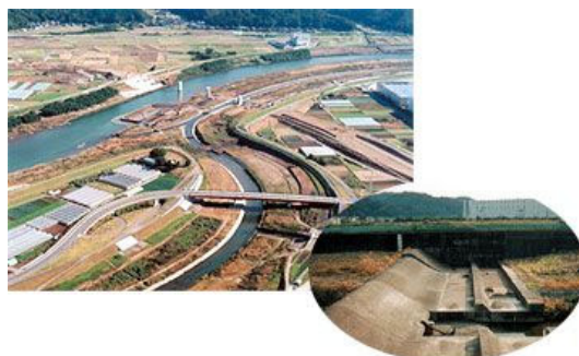
写真 1.2.10 乙津川分流堰（溢流堰）
