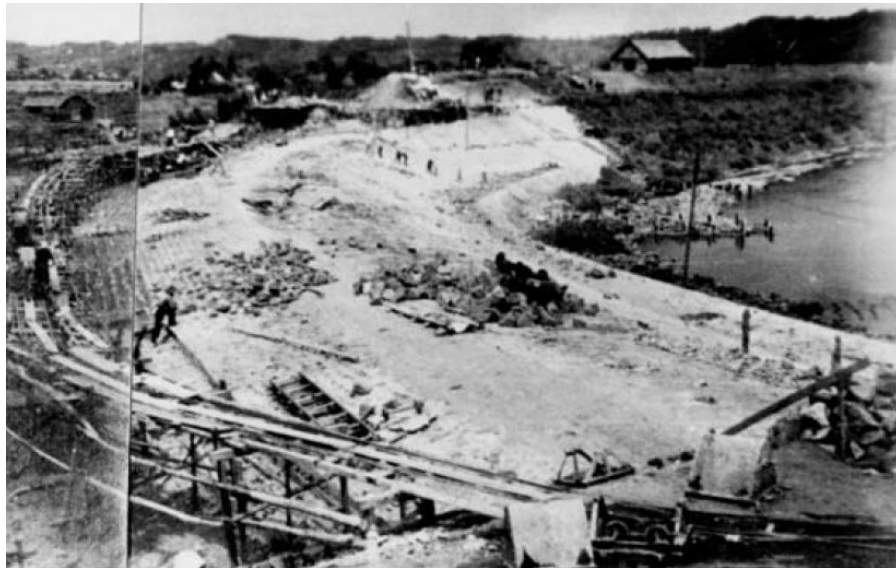
写真 1.2.2 昭和 18 年(1943 年)当時の築堤状況（大野川 8k400 左岸付近）
