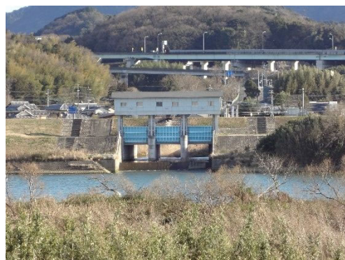
写真 2.1.4 大谷樋門(平成 21 年度完成)
