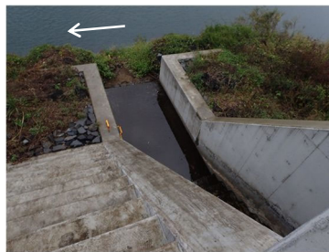
写真 2.3.20 利光第三樋門ゲート (大野川 18k700 付近)
