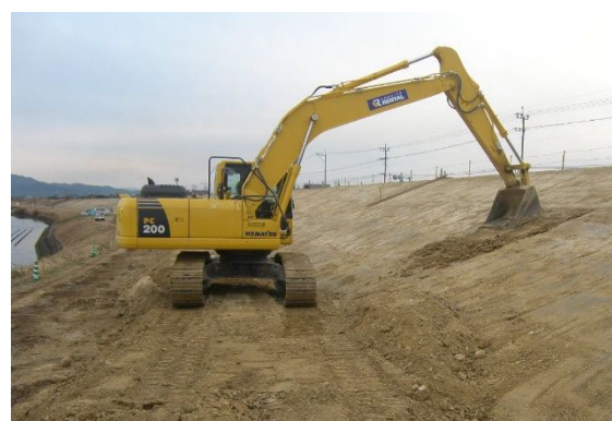
写真 5.3.3 堤防法面補修
