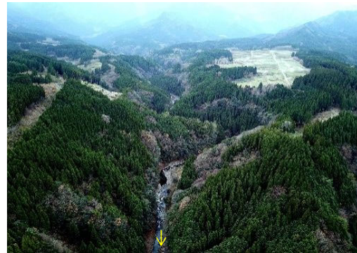
写真 1.1.1 上流部（竹田市）
