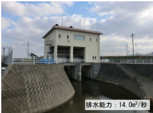
写真 2.1.2 北鼻川排水機場(平成 20 年度完成)
