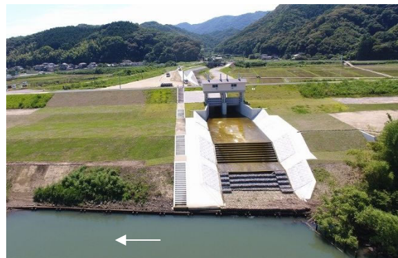
写真 5.2.5 宮谷樋門（大野川 10k4 付近）
