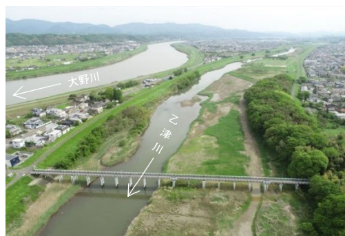
写真 5.2.3 中島橋付近（派川乙津川 4k0 付近）
