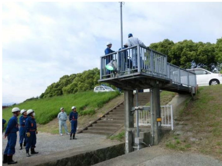
写真 5.3.4 水閘門の現地一斉点検
