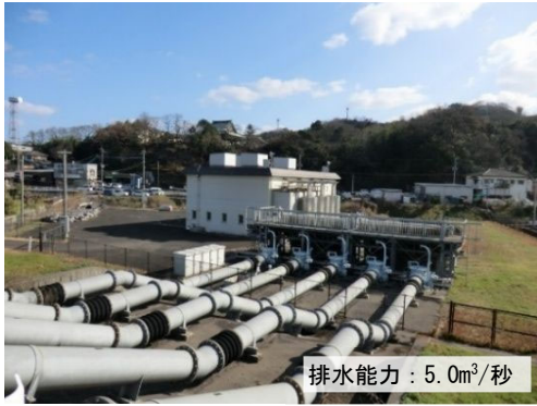
写真 2.1.1 迫排水機場(平成 15 年度完成)
