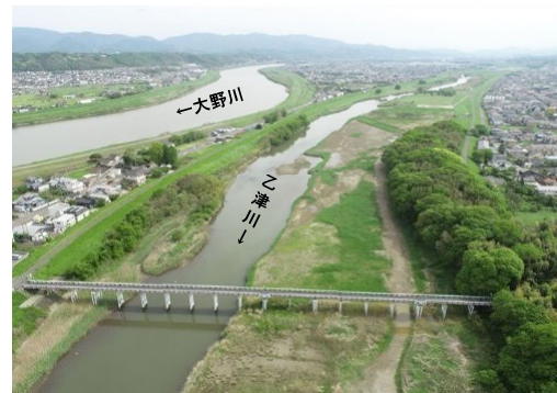
写真 1.1.3 下流部（大分市）
