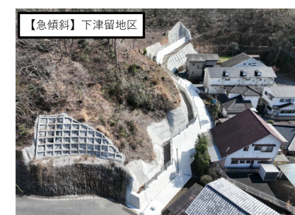
【急傾斜】下津留地区 令和7年度の取組 急傾斜地崩壊防止施設の整備
