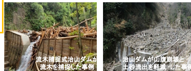
治山事業の実施による流木・土砂の流出抑制効果
