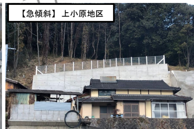
令和7年度の取組 急傾斜地崩壊防止施設の整備
