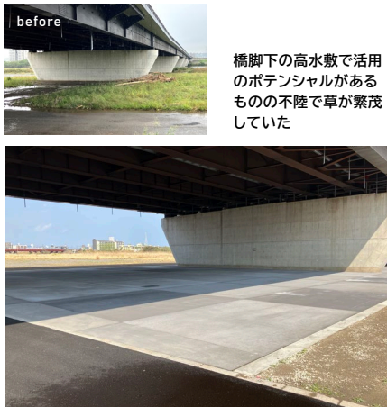
▲ R6年度整備の高水敷整正 ※Co舗装 (元町地区)
