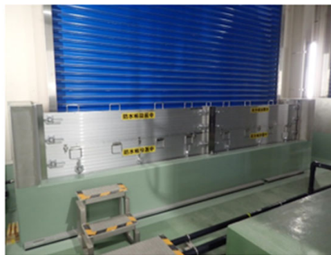
止水板の設置
