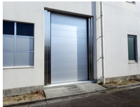
防水シャッターの設置
