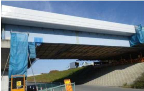
橋梁点検と補修工事で足場を共有
