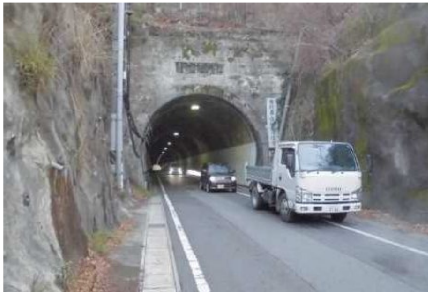
＜仁方隧道の状況＞
