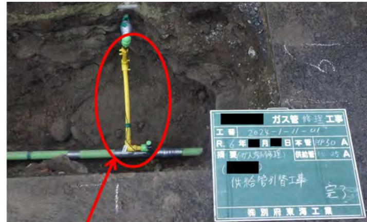
取出し部の被覆継手への交換および供給管の一部引替
