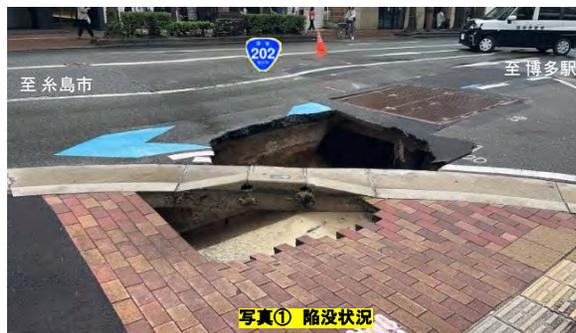
写真① 陥没状況
