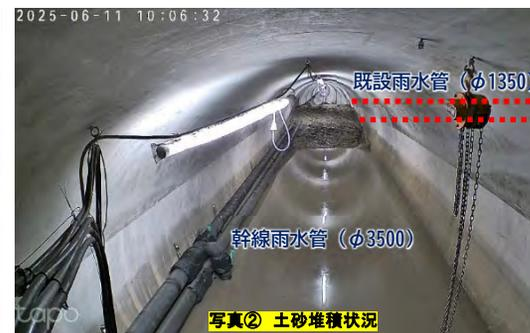
写真② 土砂堆積状況
