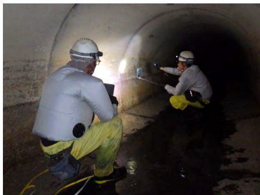
大分県（大分市） 大型口径の点検状況
