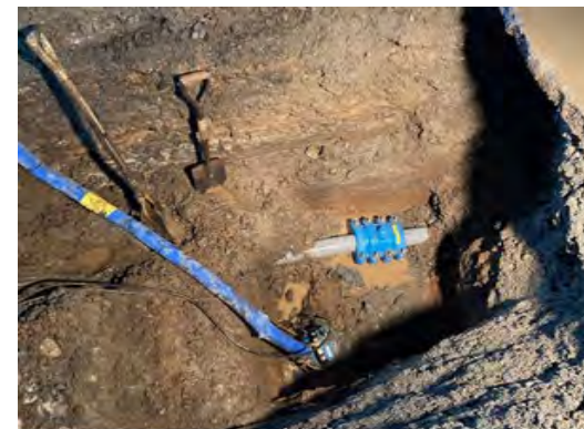
水道管 補修箇所
