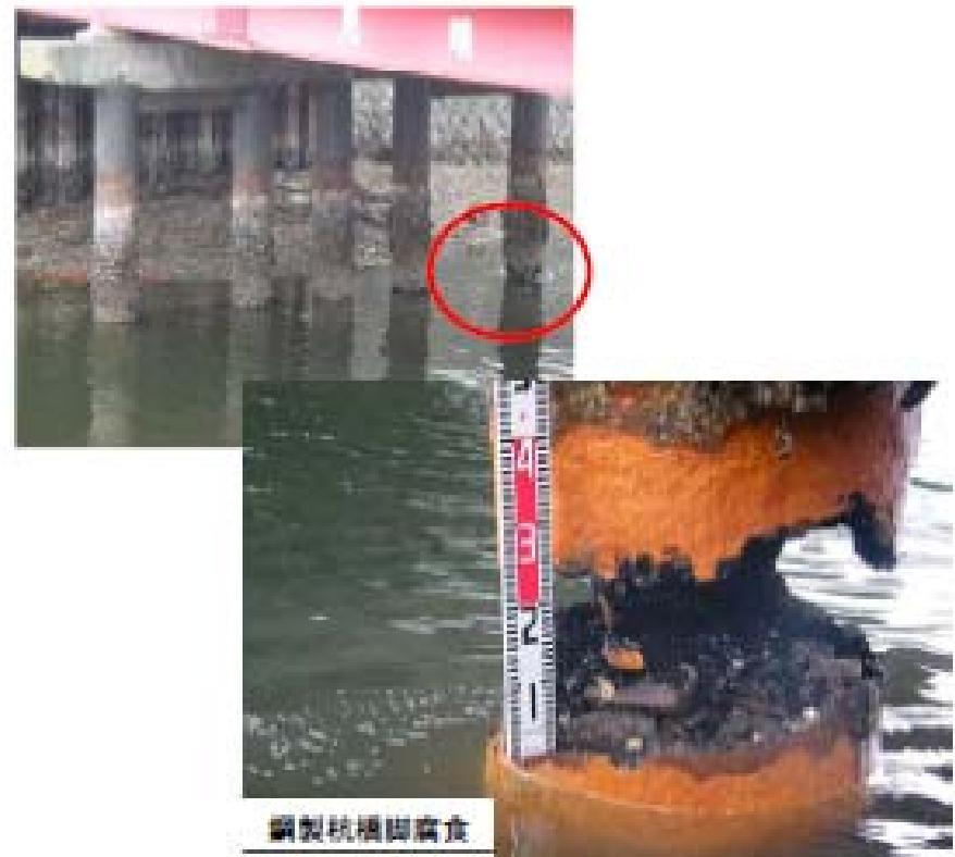
※水中部から調査を実施したところ鋼製杭橋脚に著しい腐食が確認
