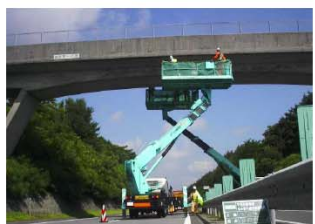
点検実施状況
