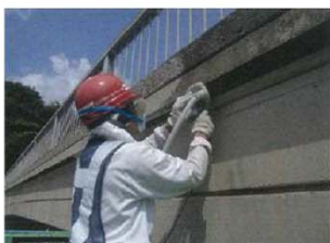
補修実施状況
