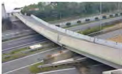
写真-2 横変位拘束構造の破壊、落橋
