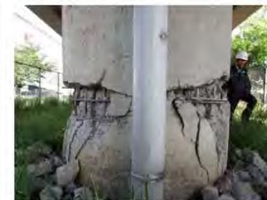
写真-7 段落し部の損傷
