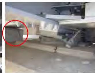
写真-6 支承の破損の状況
