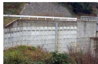
盛土(補強土壁)
