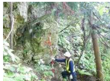
(危険度調査状況)
