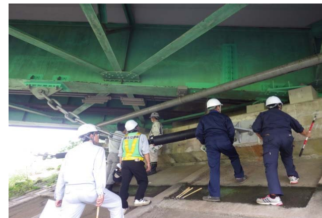
橋梁点検の研修状況
