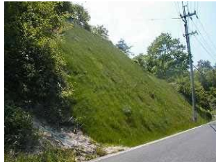
切土(法面保護)
