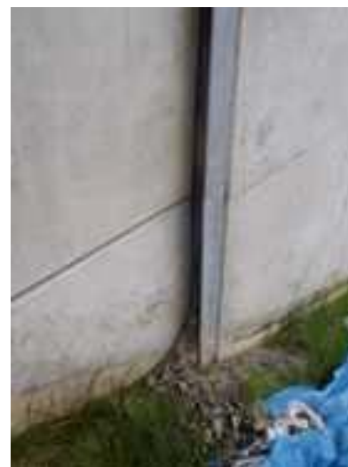
写真 土砂のこぼれ出し例
