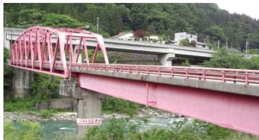
＜音沢橋の状況＞
