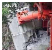
制震ダンパー取付部の損傷
