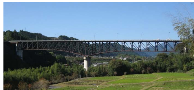
＜乙姫大橋の状況＞
