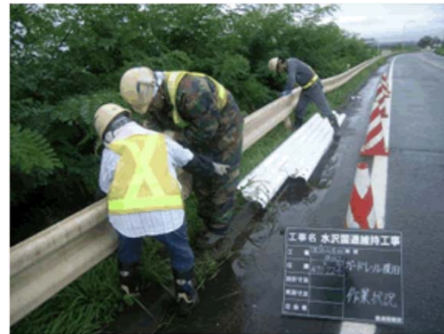
＜防護柵の取替＞
