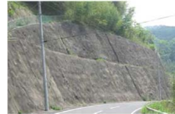
モルタル吹付
