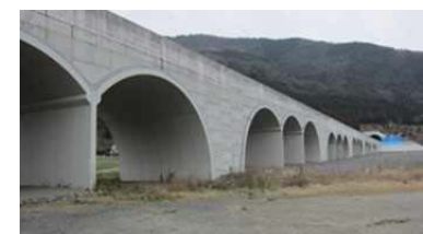
アーチカルバート
