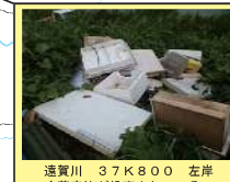
遠賀川 37K800 左岸 冷蔵庫等が投棄されている。
