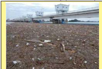
遠賀川 右岸2K000 河口堰 たくさんのごみが流れてきている。
