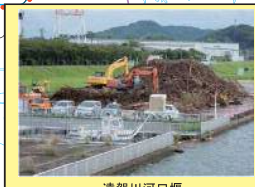
遠賀川河口堰 ゴミの陸揚げ状況
