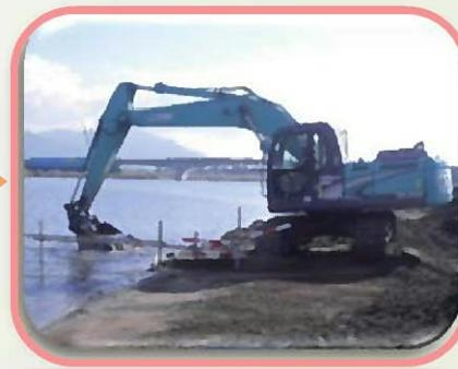
掘った土は、堤防に適した土へ改良の上、すぐ近くの堤防に利用されます。
