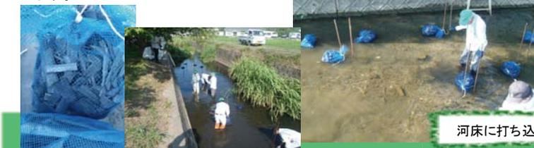
河床に打ち込んだ鉄筋に、ネットに入れた竹炭を括りつけて設置
