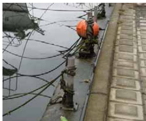
係船柱 船をつなぐための柱 (50cm 80cmが多い)
