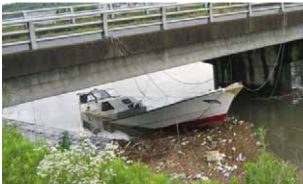
河道閉塞の恐れ(西川・道管橋)
