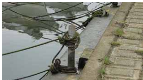
係留杭や係留環の設置による護岸の損傷
