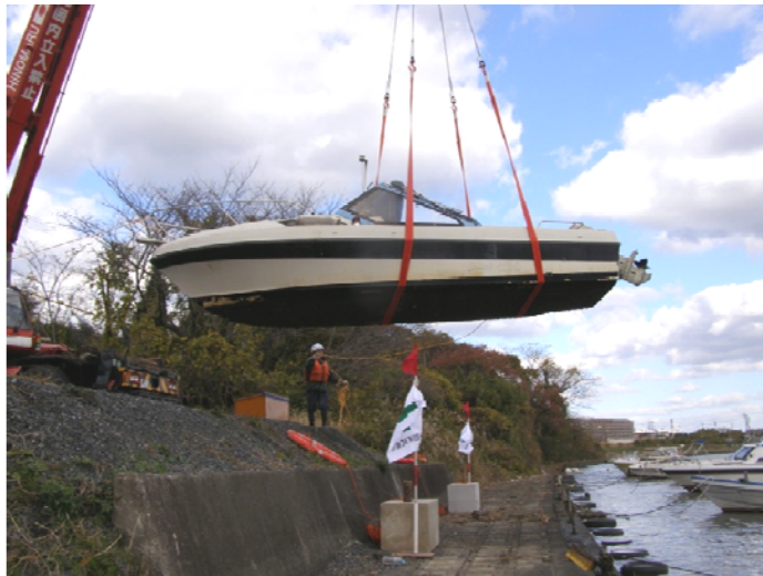
係留された船舶をつり上げ、撤去
