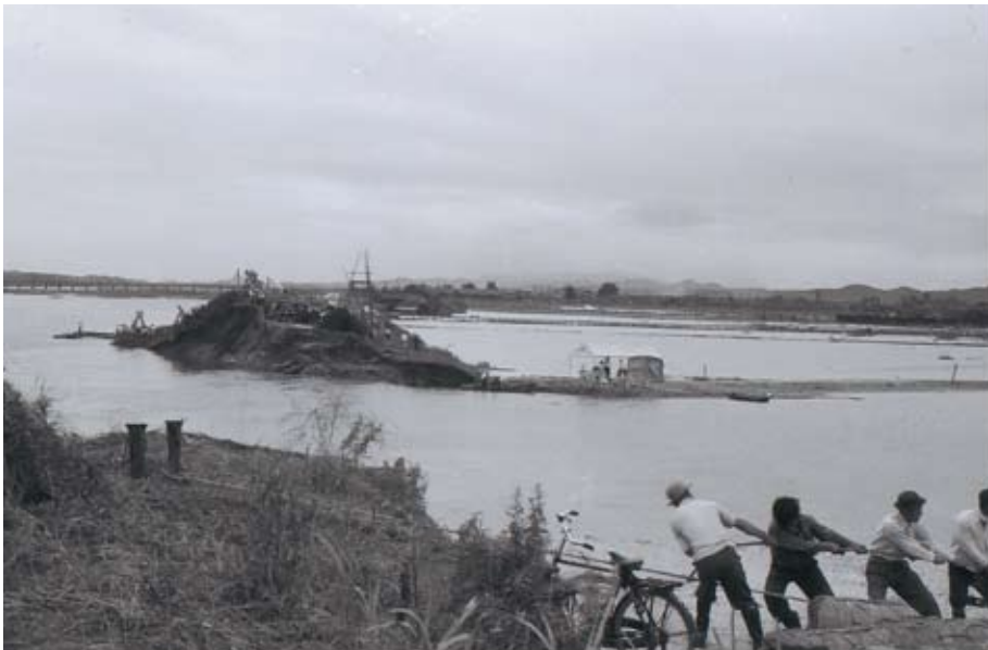
撮 影 日：昭和28年6月頃 撮影場所：直方市植木町中之江 撮影内容：集中豪雨により堤防が決壊し冠水 写真提供：栗田 利定
