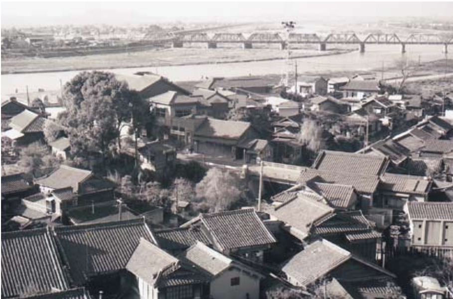
撮 影 日：昭和42年11月頃 撮影場所：旧中間町消防署より筑豊鉄橋を望む 写真提供：中間カメラ
