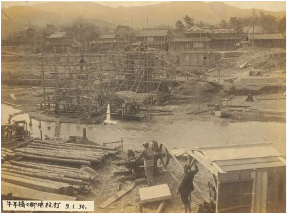
撮影日：昭和9年1月30日 撮影場所：牛年橋（現新入大橋として架け替え中） 撮影内容：橋脚の基礎杭打設の様子 写真提供：西谷 正己
