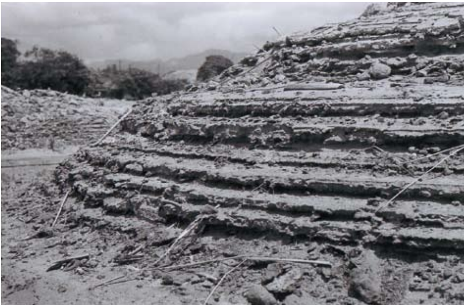
撮 影 日：昭和28年6月頃 撮影場所：上木月 撮影内容：増水から減水した後の状況（鉱害復旧時の盛土） 写真提供：栗田 利定
