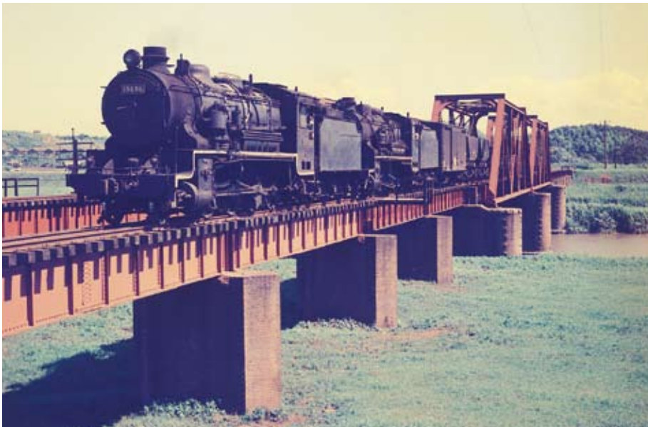
撮 影 日：昭和44年8月23日 撮影場所：直方市尾崎（遠賀川右岸20k900付近） 撮影内容：古いSLが2台のんびりと渡る昼下りの嘉麻川（遠賀川）橋梁。洗炭のため、川の水は黒く濁る。 写真提供：荒川 彰
