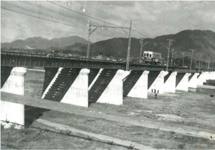
撮 影 日：昭和34年10月頃 撮影場所：直方市知古 撮影内容：筑豊電鉄鉄道橋 写真提供：島田 康子
