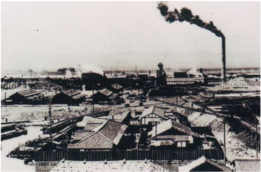
撮影日：大正3年頃 撮影場所：中間市中鶴一坑石炭積込場 撮影内容：向こうに見えるのは遠賀川 写真提供：中間カメラ
