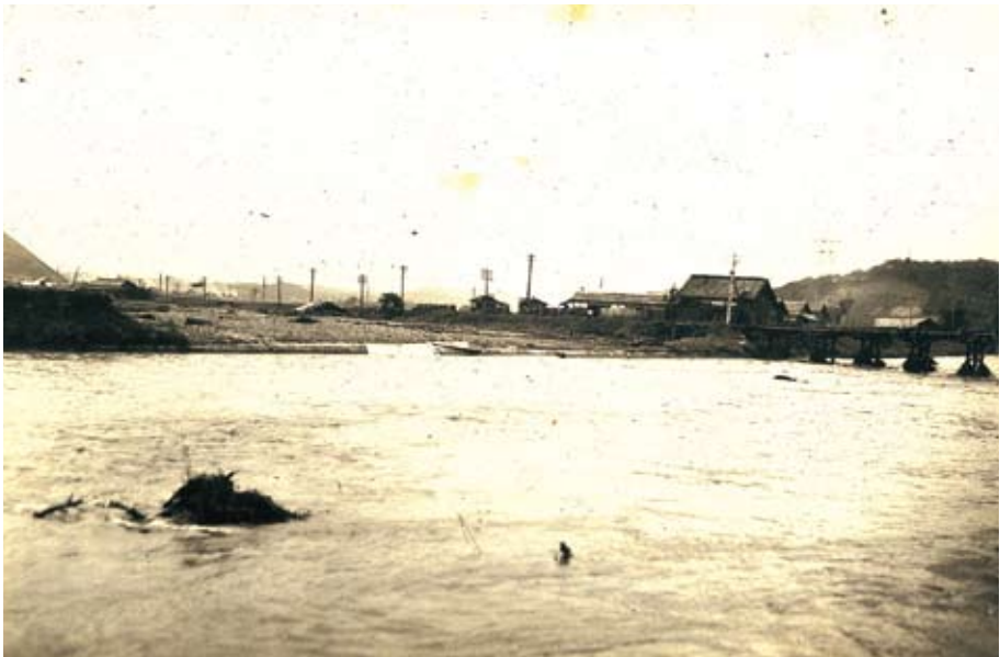
撮 影 日：昭和10年6月28日 撮影場所：田川郡後藤寺町大字弓削田地内 撮影内容：中元寺川堤防流失実況 写真提供：荒木 征男
