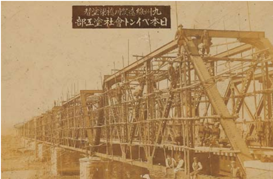
撮影日：明治40年（推定） 撮影場所：鹿児島本線遠賀川鉄橋工事（遠賀町） 写真提供：金子 浩道
