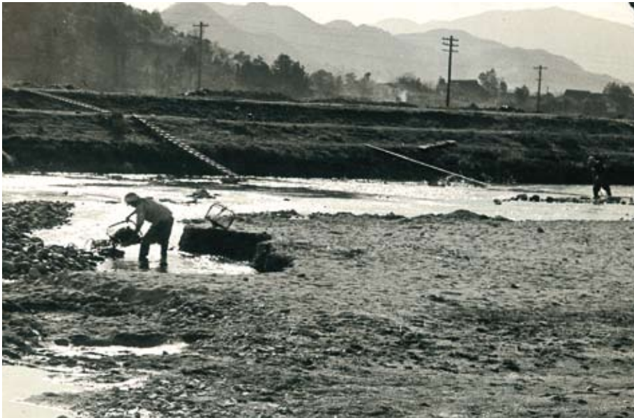
撮 影 日：昭和20年代～30年頃 撮影場所：嘉麻市（元碓井町）光代の井堰附近 撮影内容：工事用資材の川砂、砂利石を採取する風景 写真提供：原田 益雄・原田 敏子
