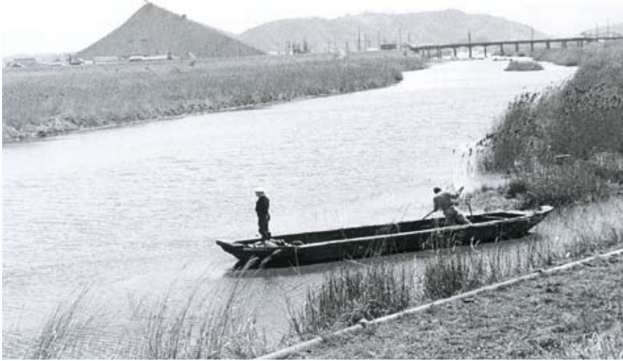
撮 影 日：昭和28年12月2日 撮影場所：飯塚市若菜、遠賀川支流 撮影内容：日鉄の潤野炭鉱の硬山をバックに、農夫の人達がボートで渡っている風景（現在のコスモスコモン付近） 写真提供：廣津 繁義
