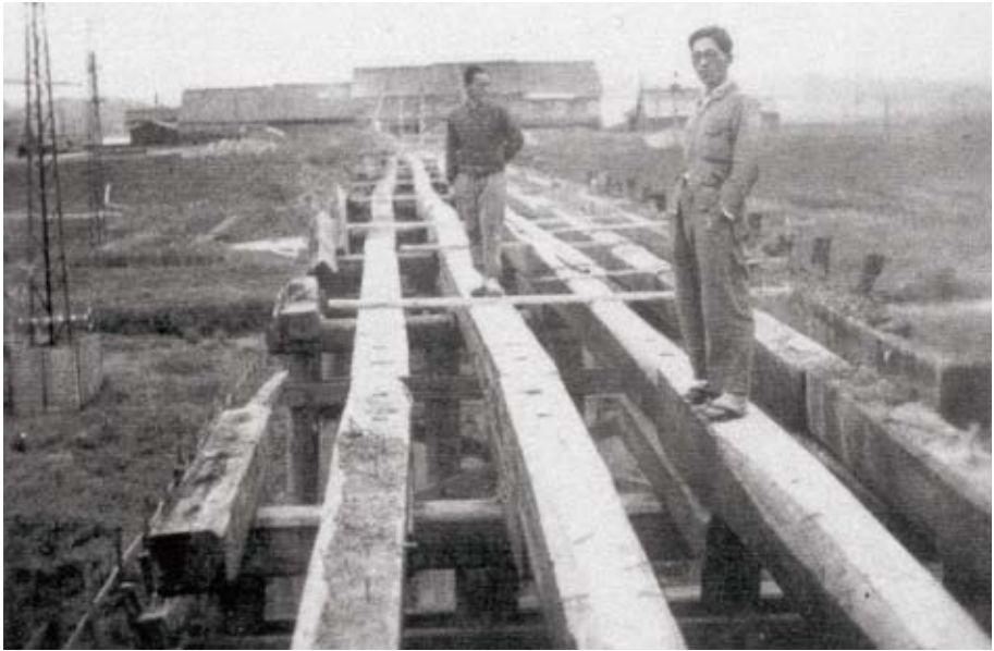
撮影日：昭和25年頃 撮影内容：穂波川橋架け替え工事により東町橋に。正面は旧朝日町。この場所には現在沈下橋が架かっている。 写真提供：竹下 茂木
