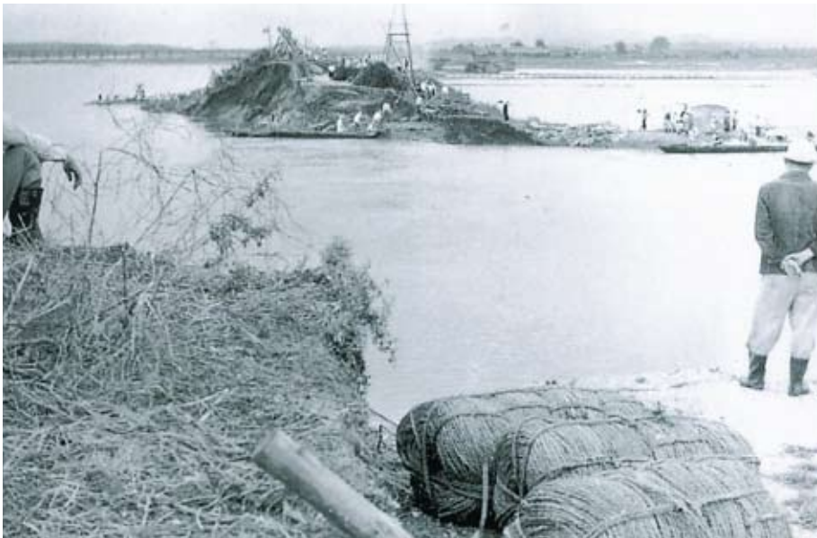
撮 影 日：昭和28年6月30日 撮影場所：直方市植木町中之江 （鞍手郡鞍手町現JR鞍手駅付近） 撮影内容：昭和28年6月26日の梅雨の長雨による北部九州水害時、遠賀川決壊3日後、復旧工事。 写真提供：加島 昭三
