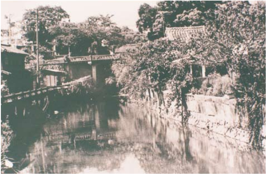
撮影場所：中間市唐戸を下流から見る。 撮影内容：川岸に手すりが作られているので、堀川に舟が通らなくなって、ある程度の年月がたった頃と思われる。水量は多い。 写真提供：香月 靖晴
