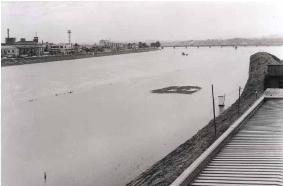
撮 影 日：昭和46年7月頃 撮影場所：旧建設省遠賀川工事事務所 撮影内容：出水の日、庁舎屋上より本川下流側を望む。左岸には旧市庁舎が見える。導流堤には何も無い。 写真提供：荒川 彰
