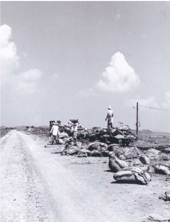
撮 影 日：昭和28年8月頃 撮影場所：直方市植木町中之江 撮影内容：復旧作業 写真提供：栗田 利定
