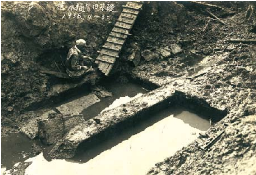
撮 影 日：昭和11年4月30日 撮影場所：犬鳴川植木花の木 山田川引込み水樋管 撮影内容：犬鳴川から山田川へ水を引き込む、花の木樋管旧基礎改築工事の様子。 写真提供：松尾 治己
