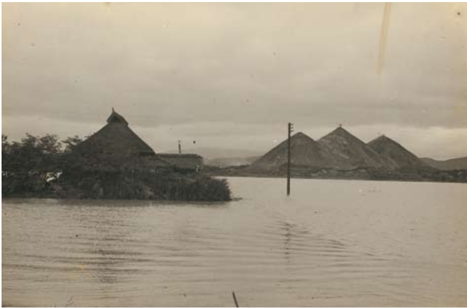
撮 影 日：昭和28年6月頃 撮影場所：鞍手郡剣村小牧の筑豊本線線路より 撮影内容：犬鳴川が遠賀川へ合流する地点。洪水により植木 側堤防決壊する。（今は無きボタ山とその周辺） 写真提供：松尾 治己
