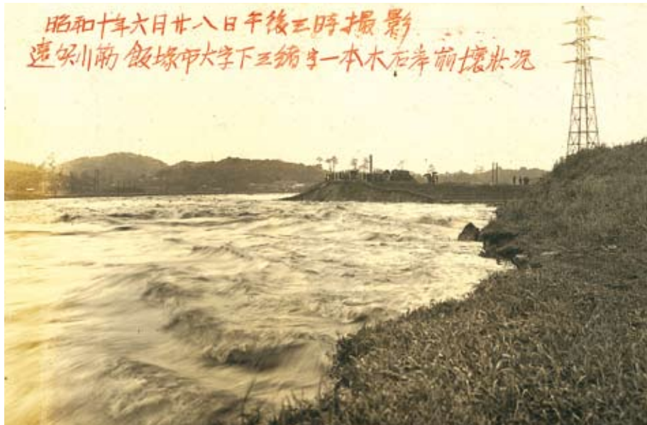
撮 影 日：昭和10年6月28日 撮影場所：飯塚市大字下三緒字一本木右岸 撮影内容：遠賀川右岸の崩壊状況 写真提供：荒木 征男
