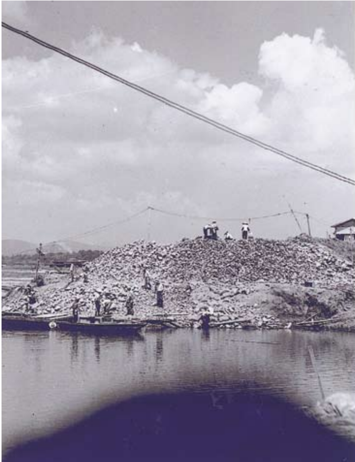
撮 影 日：昭和28年7月頃 撮影場所：直方市植木町中之江 撮影内容：復旧作業 写真提供：栗田 利定
