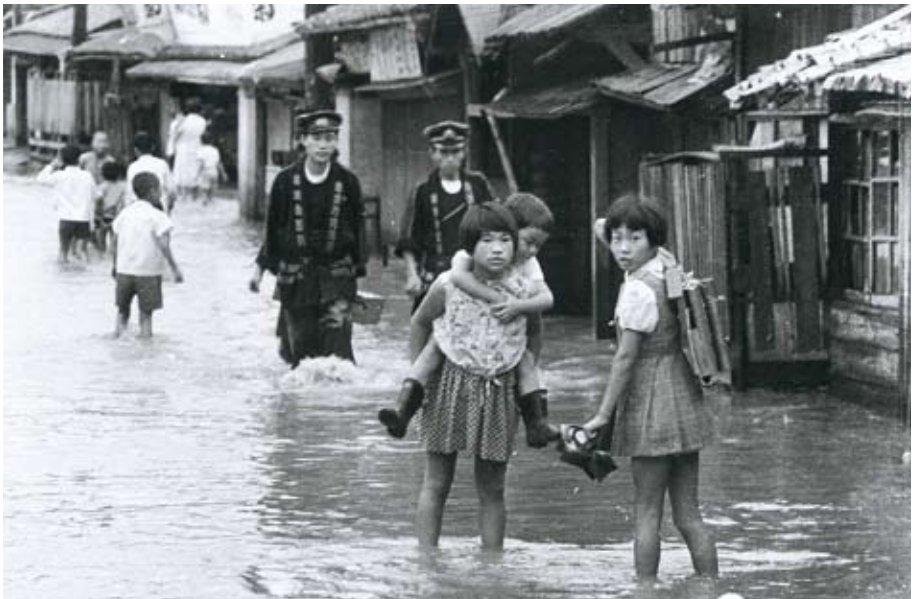
撮 影 日：昭和31年7月頃 撮影場所：枝国3区、八幡酒店（バス通り） 撮影内容：大雨により冠水 写真提供：廣津 繁義
