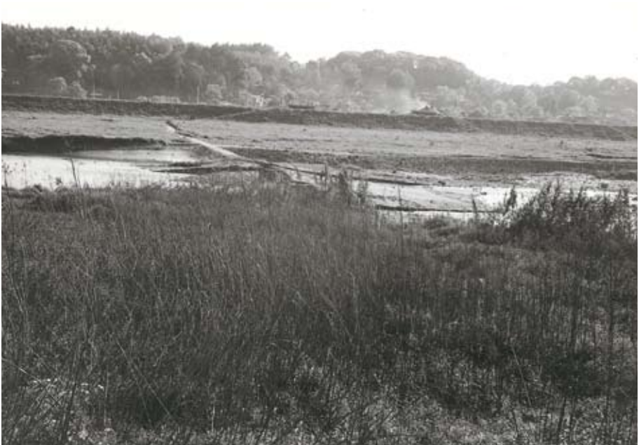
撮 影 日：昭和48年4月29日 撮影場所：直方市中泉岡森堰右岸から 撮影内容：当時はこんなに低い井堰だった。 写真提供：香月 靖晴
