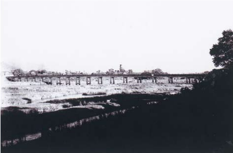
撮 影 日：昭和20年10月頃 撮影場所：中間市垣生 撮影内容：中間速賀橋。現在新速賀橋にかわっている。 写真提供：栗田 利定
