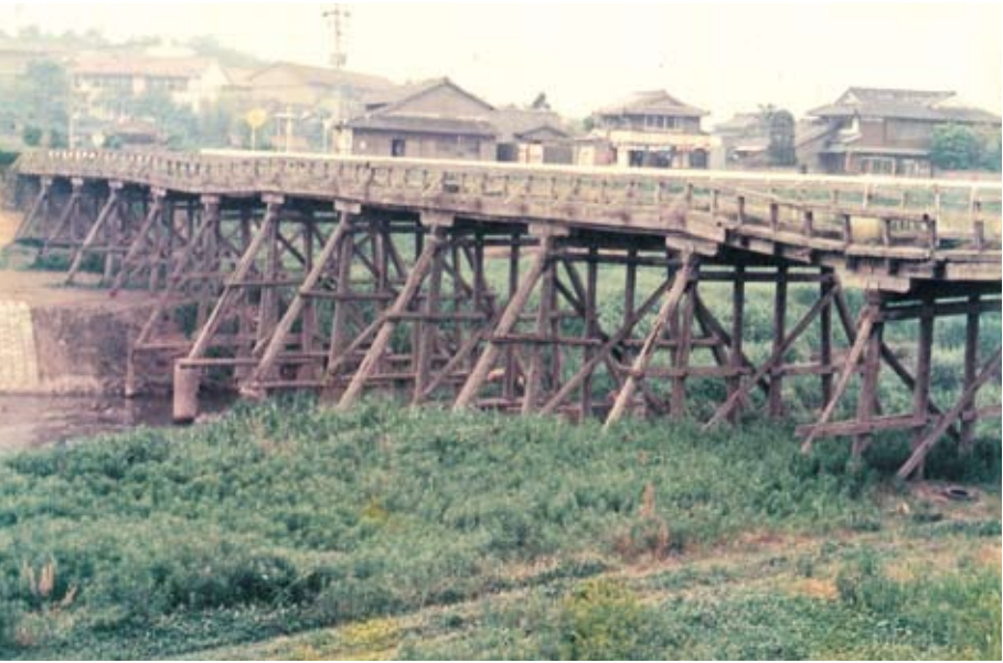
撮 影 日：昭和52年頃 撮影場所：飯塚市鶴三緒 撮影内容：嘉麻川に架かる橋 写真提供：浦田 良雄
