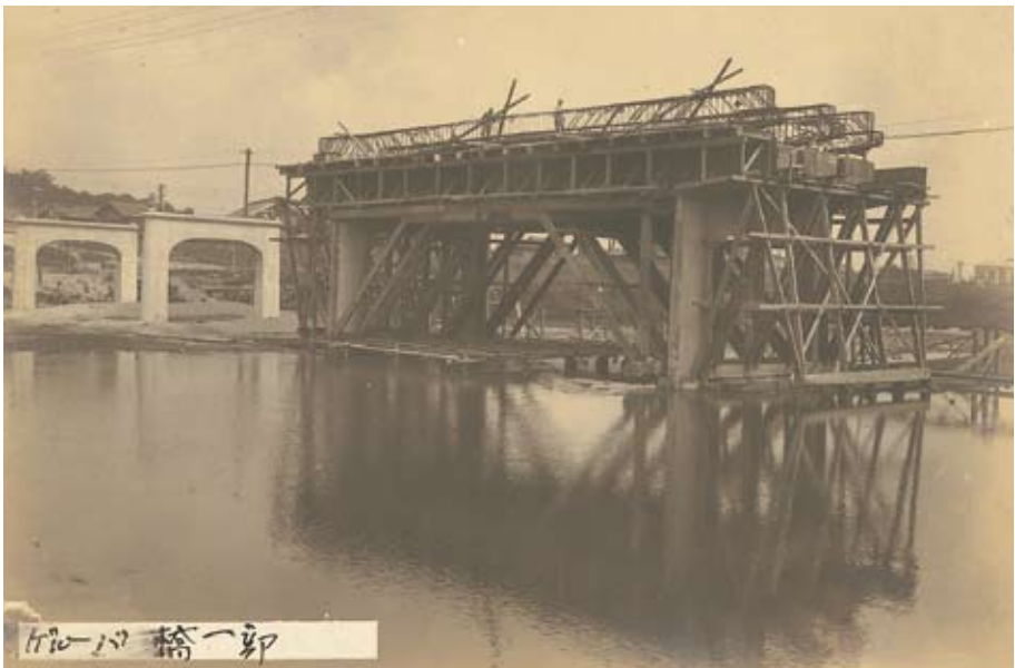
撮影場所：勘六橋（架け替え中） 写真提供：西谷 正己
