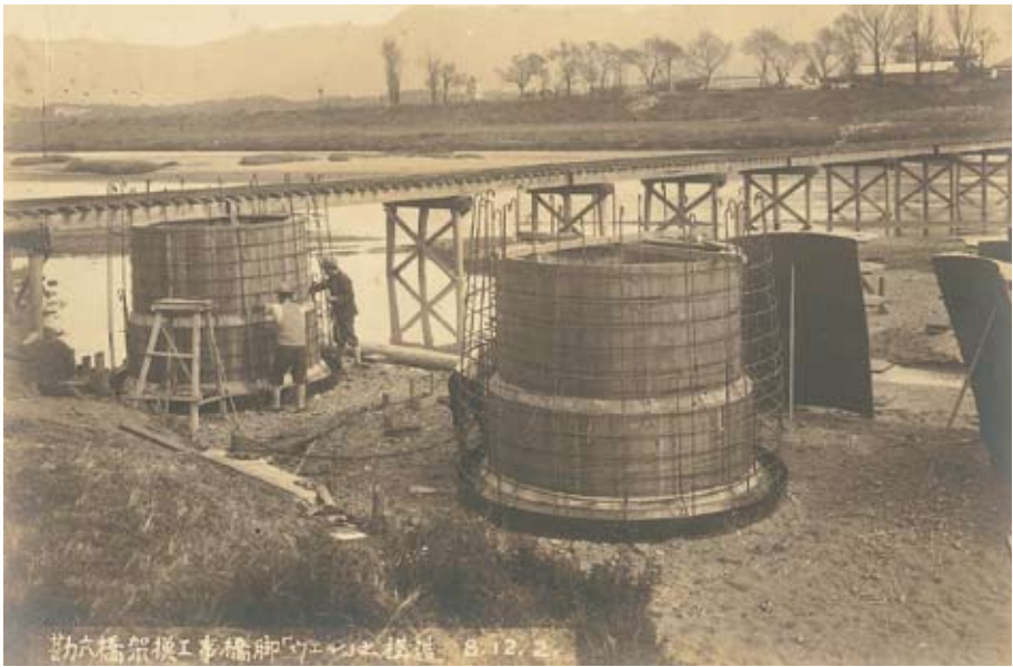
撮 影 日：昭和8年12月2日 撮影場所：勘六橋（架け替え中） 写真提供：西谷 正己
