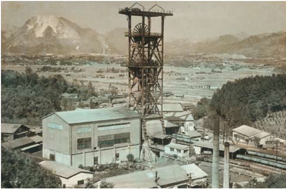
撮 影 日：昭和35年頃 撮影場所：田川市伊加利（彦山川左岸の高台より） 撮影内容：彦山川を挟んで石炭採掘施設（黒ダイヤ）と、セメントの原石山香春岳（白ダイヤ）全盛時代。 写真提供：矢野 日出東
