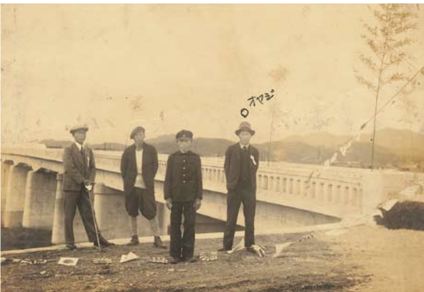
撮影場所：境橋 撮影内容：竣工式典 写真提供：西谷 正己
