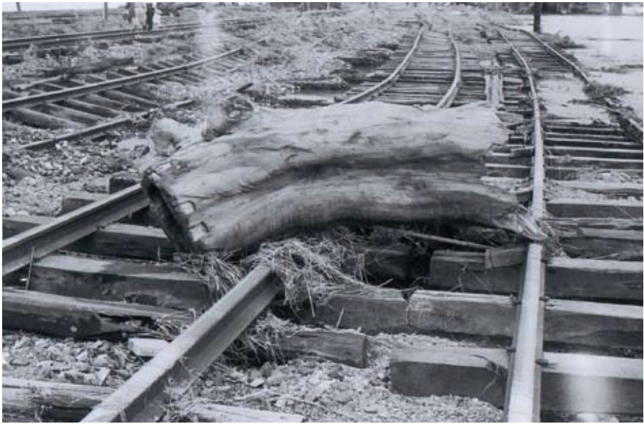
撮 影 日：昭和28年6月頃 撮影場所：鞍手郡剣村小牧信号所付近（現鞍手町鞍手駅付近） 撮影内容：洪水に流され、線路に乗った流木 写真提供：栗田 利定
