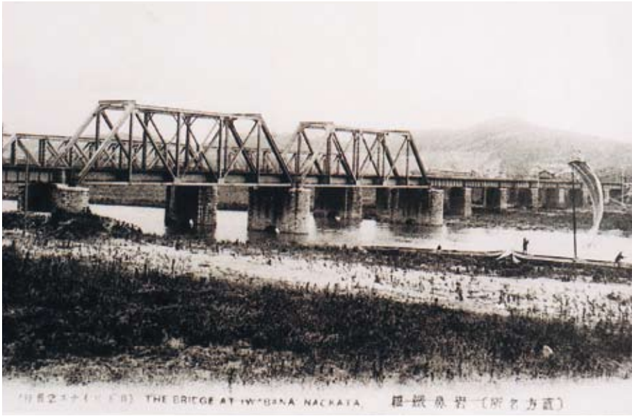
撮影日：明治時代 撮影内容：岩鼻鉄橋 写真提供：中間カメラ
