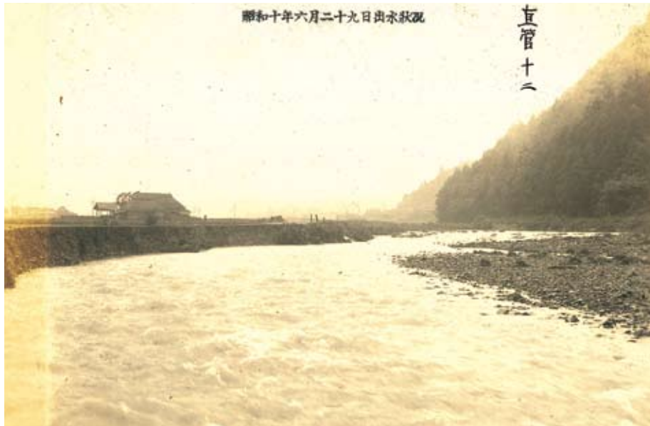
撮 影 日：昭和10年6月29日 撮影場所：鞍手郡山口村山口地内 撮影内容：山口川堤防決潰 写真提供：荒木 征男
