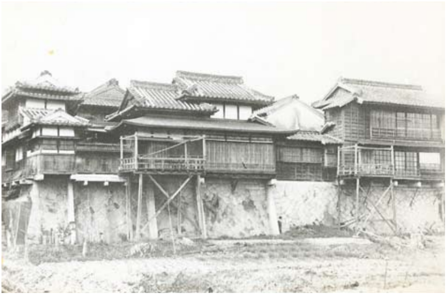
撮影場所：国道200号小竹交番所裏 写真提供：尾上 礼子
