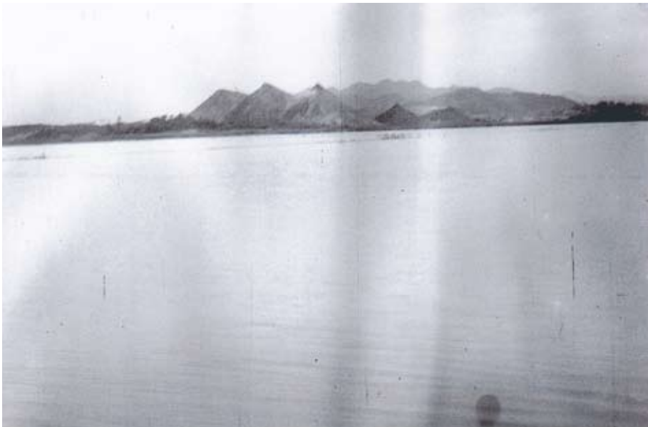
撮 影 日：昭和28年6月頃 撮影場所：上木月 撮影内容：水害による冠水。三菱鉱業新入坑のボタ山 写真提供：栗田 利定
