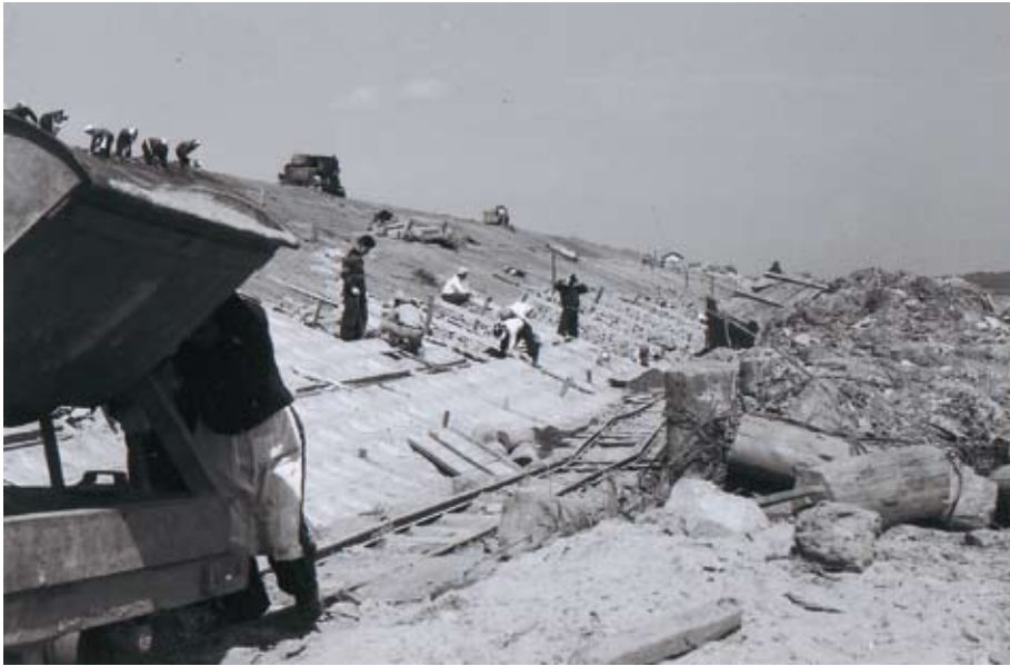
撮 影 日：昭和29年3月 撮影場所：直方市植木町中之江 撮影内容：昭和28年水害の復旧作業 写真提供：栗田 利定
