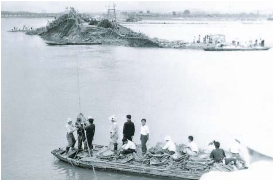
撮 影 日：昭和28年6月30日 撮影場所：直方市植木町中之江 撮影内容：梅雨の長雨による北部九州水害時、遠賀川決壊3日後の復旧工事の様子 写真提供：加島 昭三
