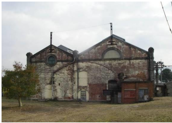
写真 1 遠賀川水源地ポンプ室
