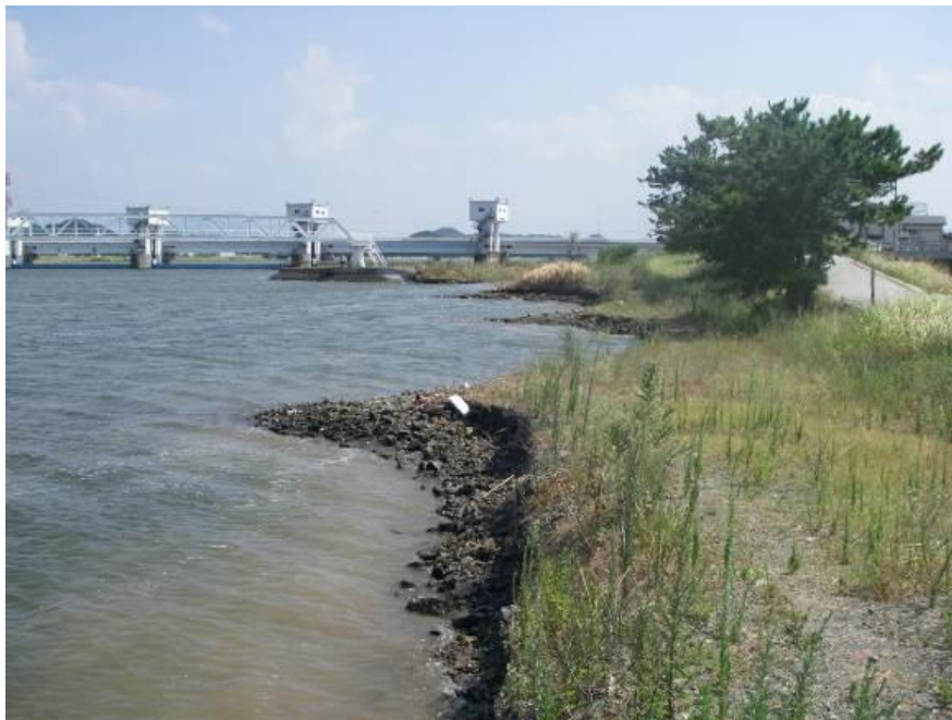
写真 36 水制工による干潟の保全
