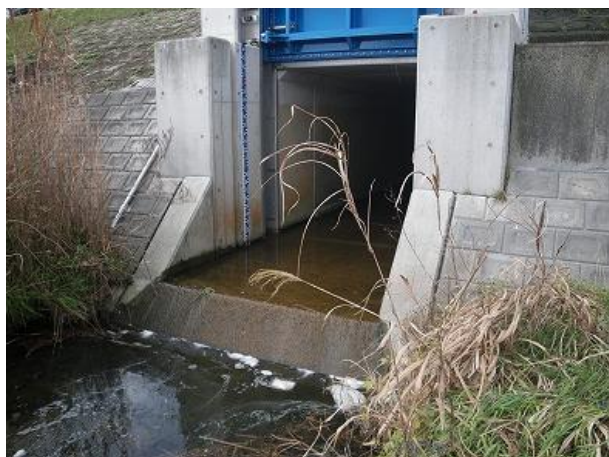
写真 7 樋門・樋管の排水路の落差
