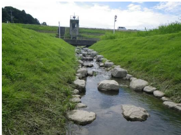
写真 14 御徳地区（川表水路）
