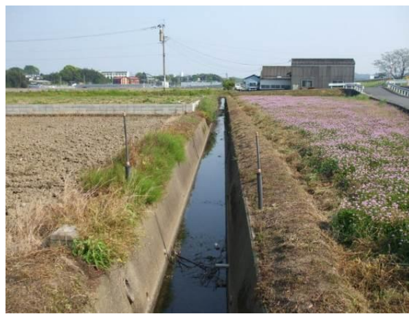
写真 8 農業用排水路と水田の段差
