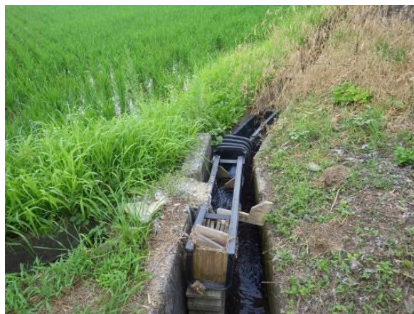
写真 15 御徳地区水田魚道（川裏）
