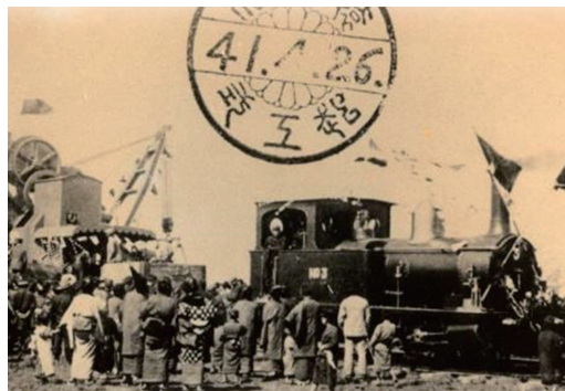
改修工事起工式（明治41年4月）
