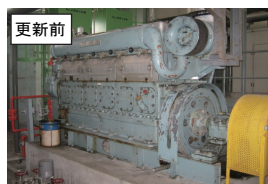
原動機各部の老朽化
