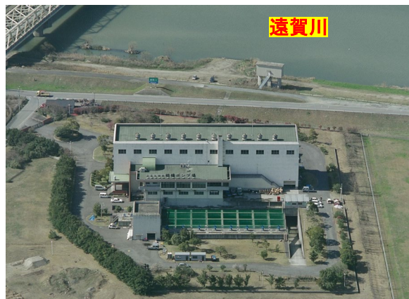
<楠橋ポンプ場全景>
