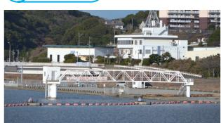
河口堰の上下流に2箇所づつあり、上流の水位と下流の水位を確認し、堰の操作を行います。
