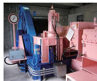
ゲート機械室には、大きな鉄のゲートを引き上げるため、電気で動く巻き上げ機(直径2.5m)や、非常用エンジンなどがあります。
