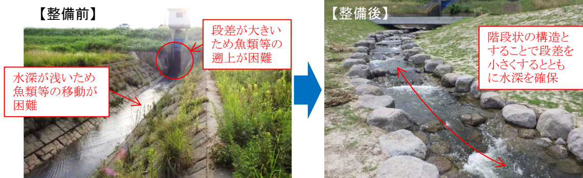
写真 5.1.7 横断的連続性再生のための排水路改良（目尾地区）
