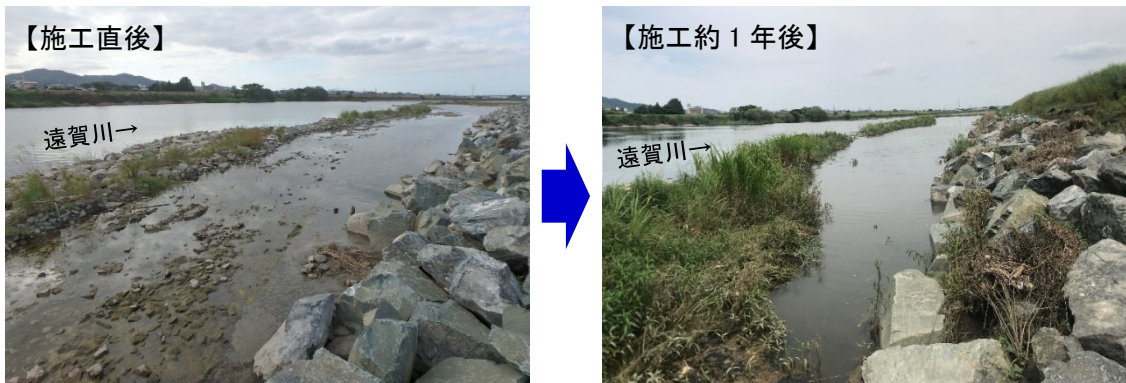
写真 5.1.4 河道掘削に伴う湿地環境の創出
