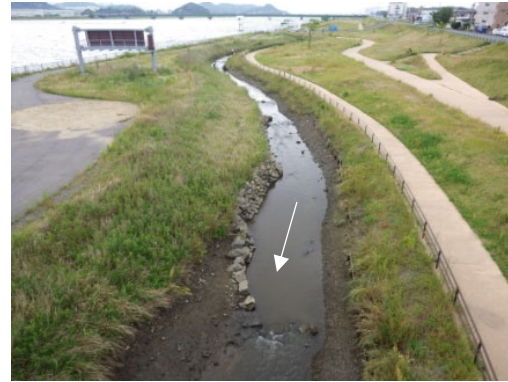
写真 2.3.19 多自然魚道 (上流側)
