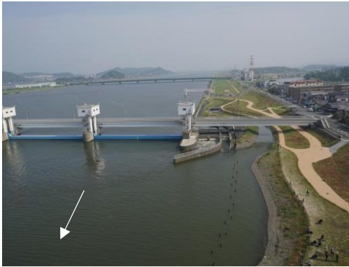
写真 2.3.18 遠賀川河口堰の 多自然魚道
