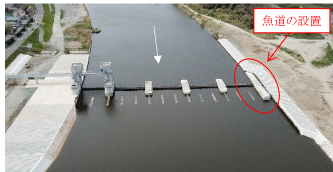
写真 5.1.6 堰改築とあわせた魚道整備（中間堰）
