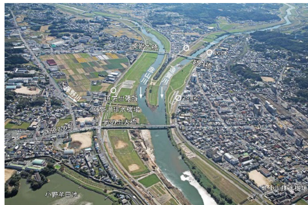
写真 2.3.3 遠賀川中流部（直方市）
