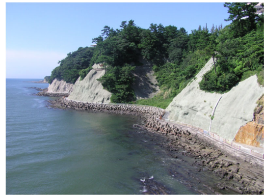
写真 2.3.36 波懸け遊歩道 (芦屋町)
