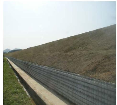
堤防のり尻に設置したドレーン工
