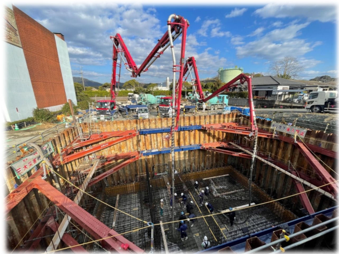
庄司川排水機場増設工事の状況(令和5年3月2日)
