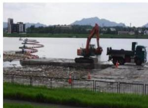
岸に引き寄せたゴミをバックホウで陸揚げしてダンプで平地に移動する。
