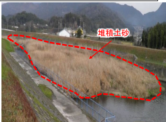
河道の緊急維持掘削を実施
