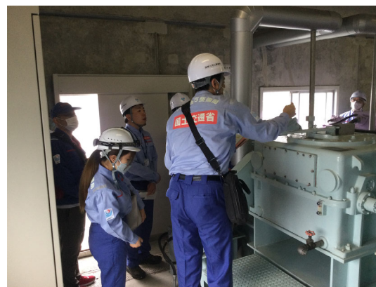
電動モーターからエンジンへの動力切替
