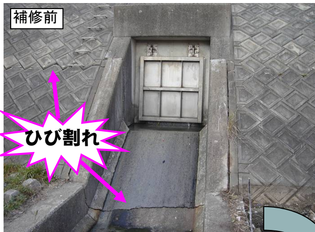
河川維持修繕による対応状況 【護岸・樋管開水路補修】
