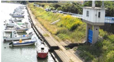
排水樋門の前面を塞ぐ係留船舶
