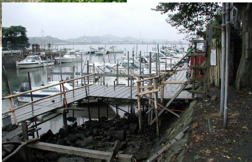
栈橋 汐入川周辺
