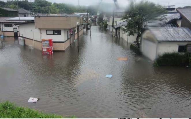
写真①R2.7浸水状況
