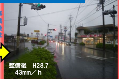
雨水幹線整備後状況
