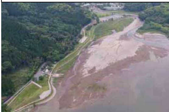
堆砂除去工事前（令和2年6月5日時点）
