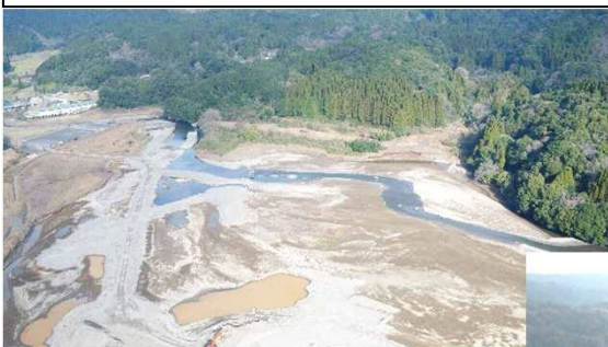
堆砂除去工事状況（令和5年12月時点）
