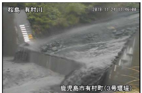
有村川 3 号堰堤
