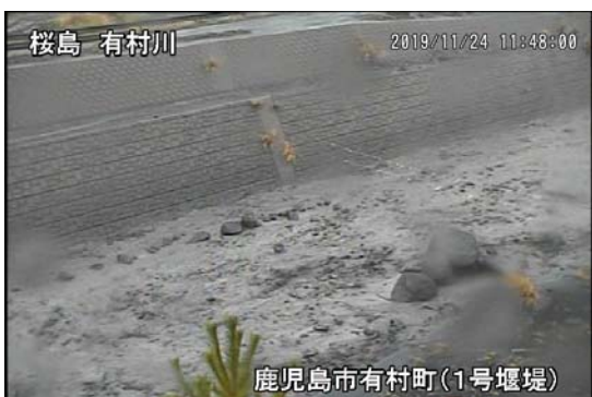
有村川 1 号堰堤
