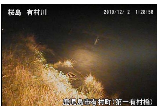
有村川 1 号橋上流右岸
