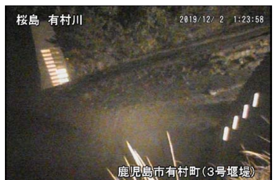
有村川 3 号堰堤
