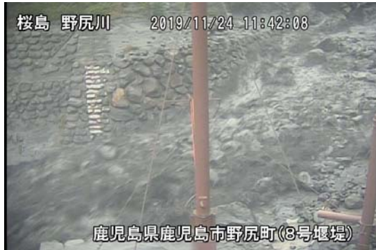
野尻川 8 号堰堤
