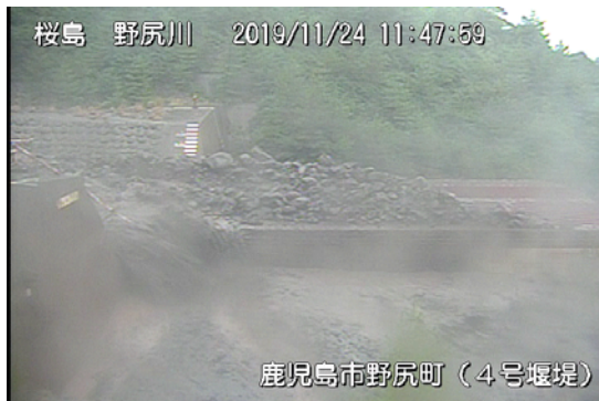
野尻川 4 号堰堤
