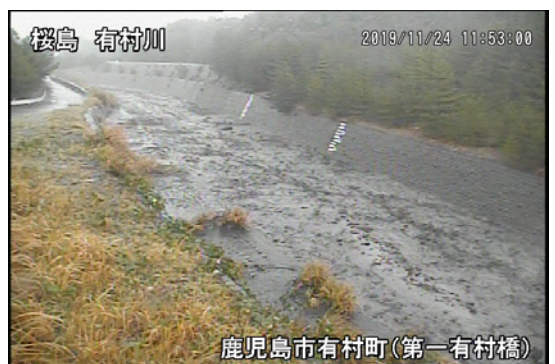
有村川 1 号橋上流右岸
