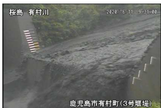
有村川 3 号堰堤
