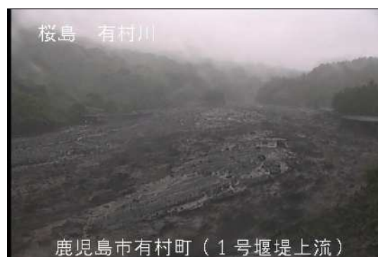
有村川 1 号堰堤上流
