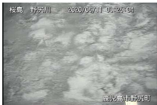
野尻川 7 号堰堤
