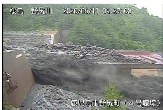
野尻川 4 号堰堤右岸
