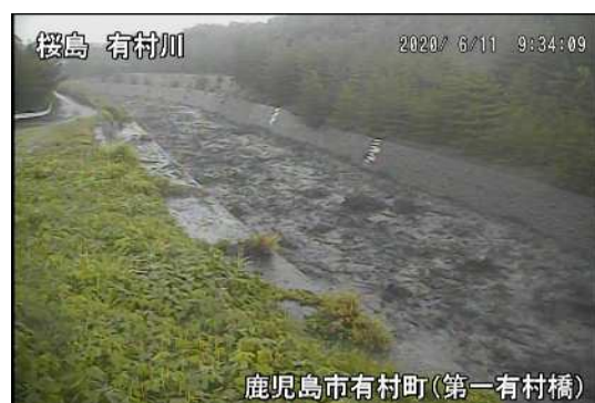
有村川 1 号橋上流右岸
