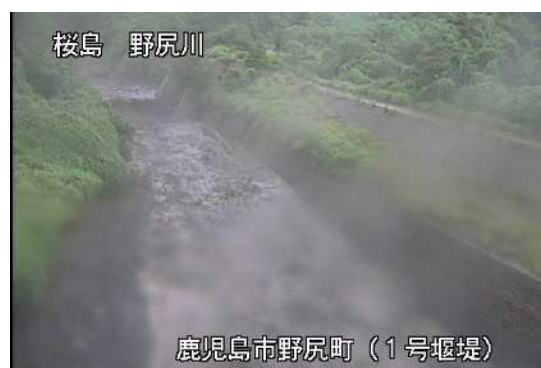
野尻川 1 号堰堤右岸
