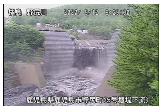
野尻川土石流の様子(9月12日)
