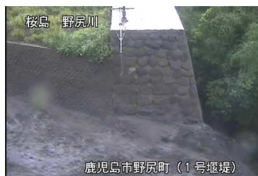
野尻川土石流の様子(9月12日)
