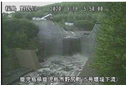
野尻川土石流の様子(9月18日)
