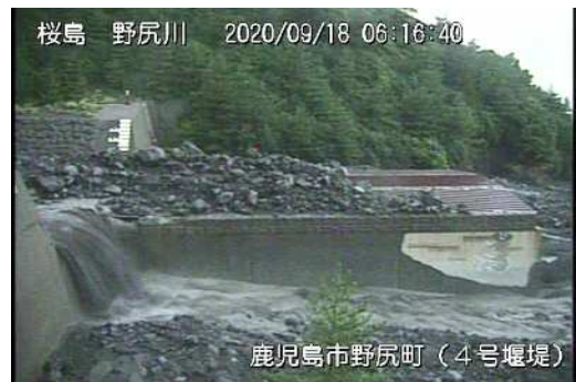
野尻川土石流の様子(9月18日)
