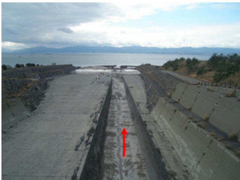
※河口から0k300付近まで土砂堆積が見られる。
