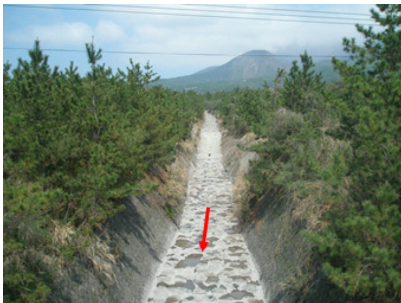
写真④ 持木橋から上流を望む（H27. 3. 19 13時10分撮影）
