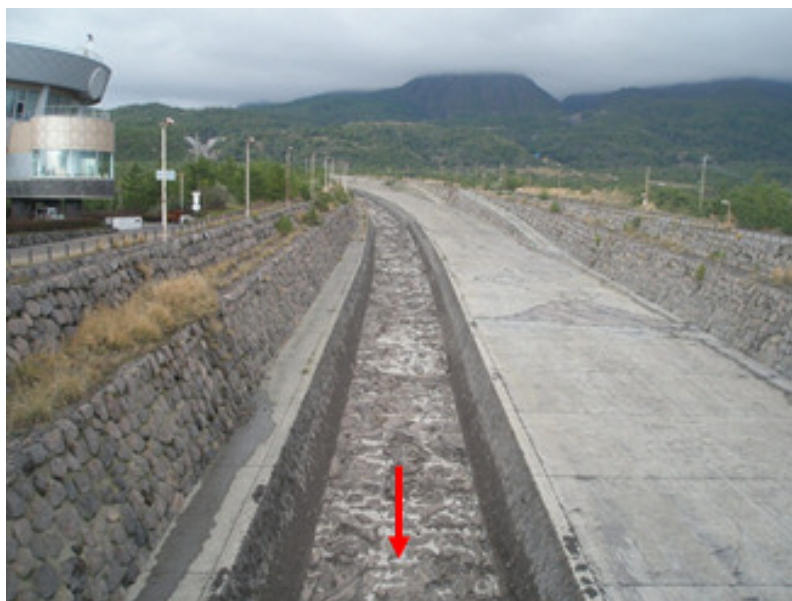
※顕著な土砂堆積は見られない。
