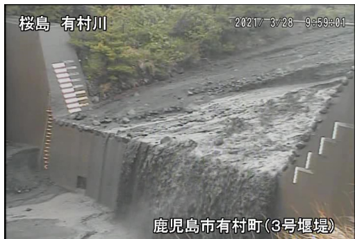
有村川土石流の様子(3月28日)
