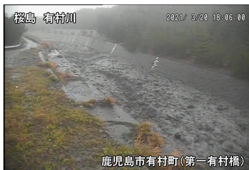
有村川土石流の様子(3月20日)
