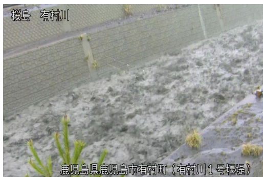
有村川土石流の様子(3月20日)
