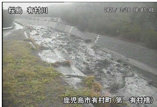
有村川土石流の様子(3月28日)
