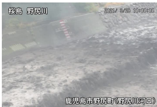
野尻川土石流の様子(3月28日)
