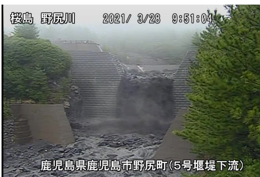
野尻川土石流の様子(3月28日)
