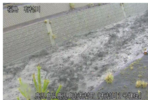
有村川土石流の様子(3月28日)
