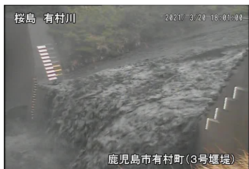
有村川土石流の様子(3月20日)
