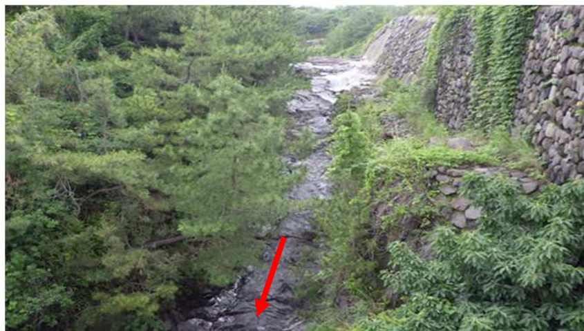
写真① 第二古里橋から上流を望む（令和3年5月28日撮影）
