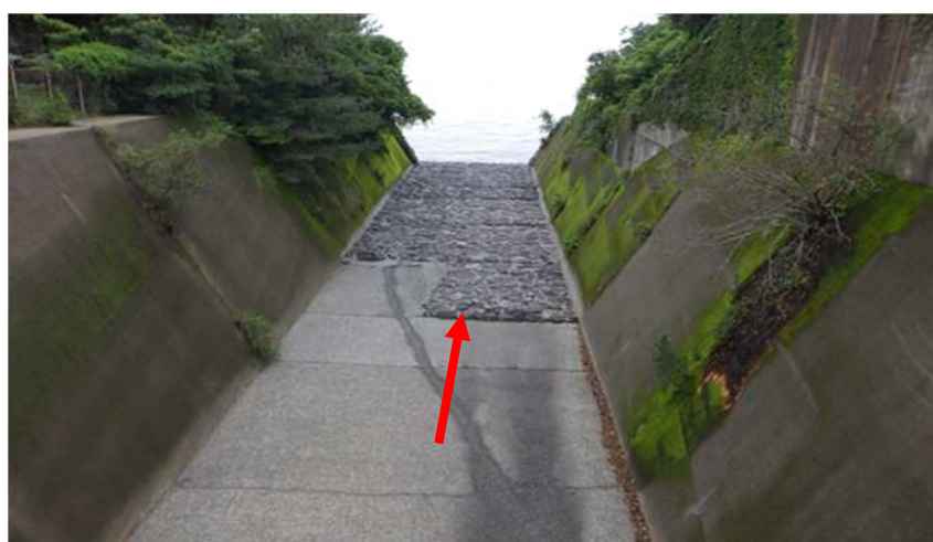
写真② 第二古里橋から下流を望む（令和2年5月28日撮影）
