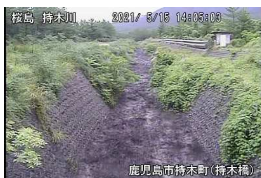
持木川土石流の様子(5月15日)
