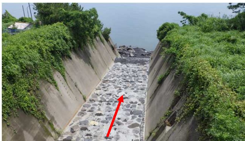
写真② 第一古里橋から下流を望む（令和3年5月28日撮影）
