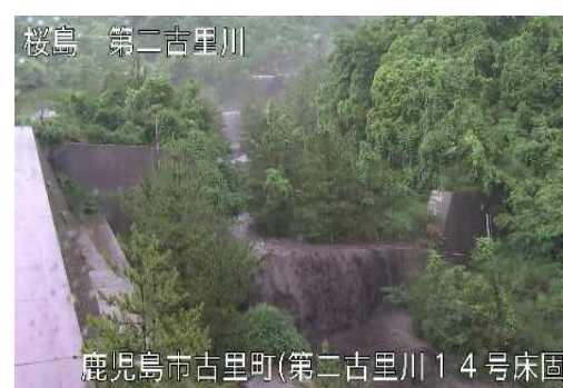
第二古里川土石流の様子(5月15日)
