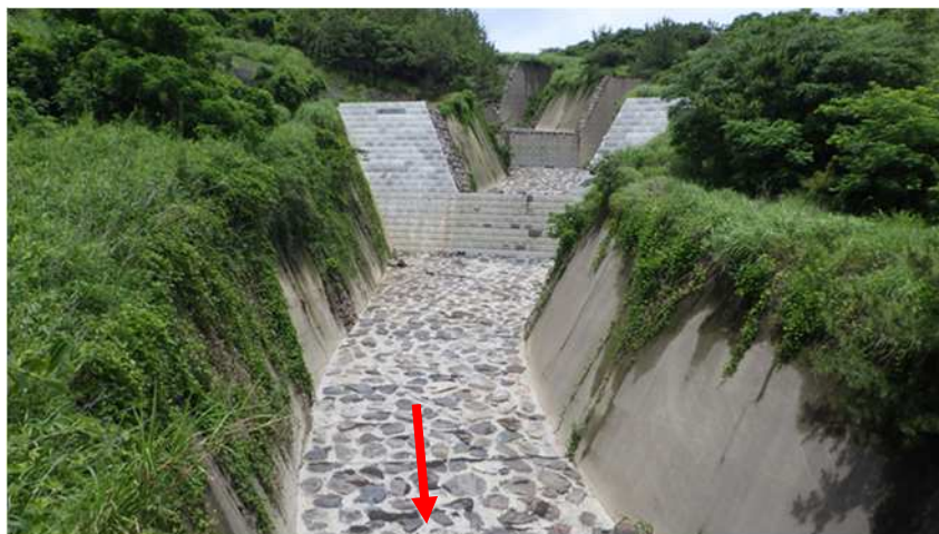
写真① 第一古里橋より上流を望む（令和3年5月28日撮影）
