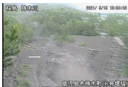
持木川土石流の様子(5月15日)
